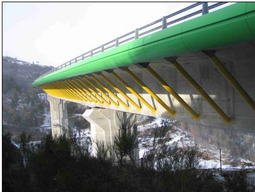
Mono-caisson avec bracons métalliques
