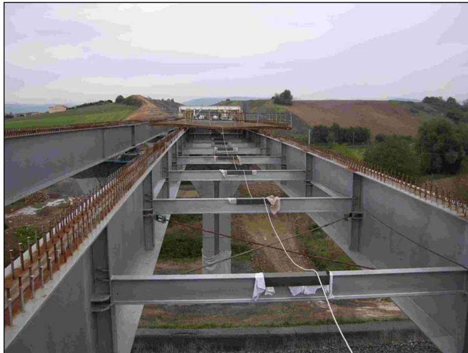
**La dalle de couverture d'épaisseur comprise entre 20 et 30 cm est connectée aux poutres métalliques et aux pièces de pont pour participer à la résistance en flexion**
