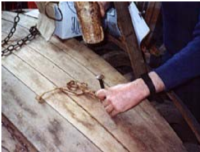
Calfatage de bateau Mise en œuvre du fond de joint avant coulage du bitume
