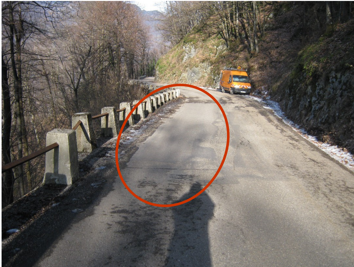
Portion d'enrobés refaite
