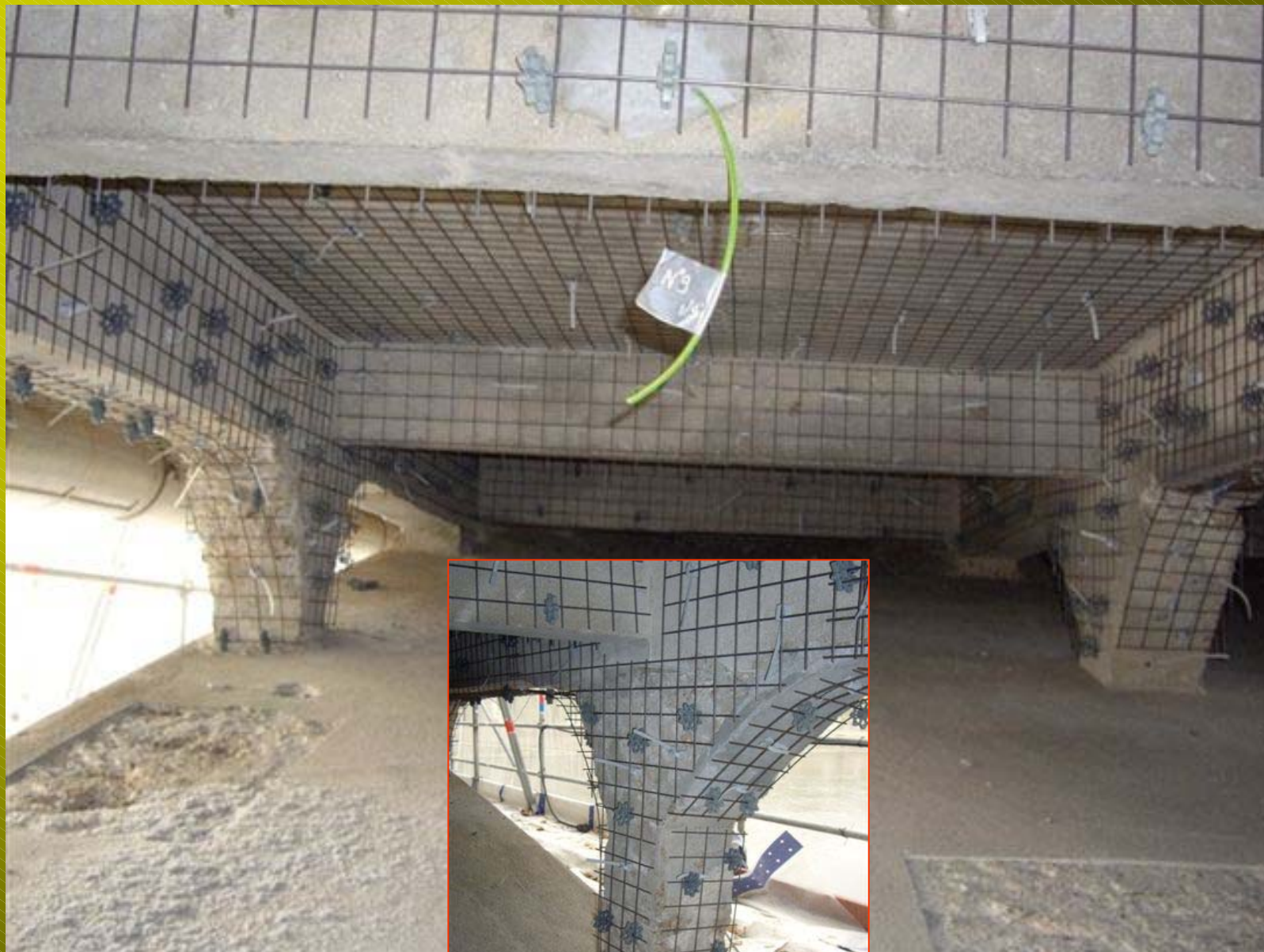
Installation du treillis Anode
