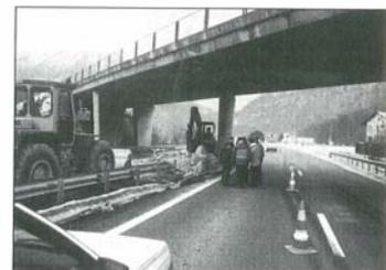
Fig. 1 - Effondrement d'un fût de pile d'un PS
