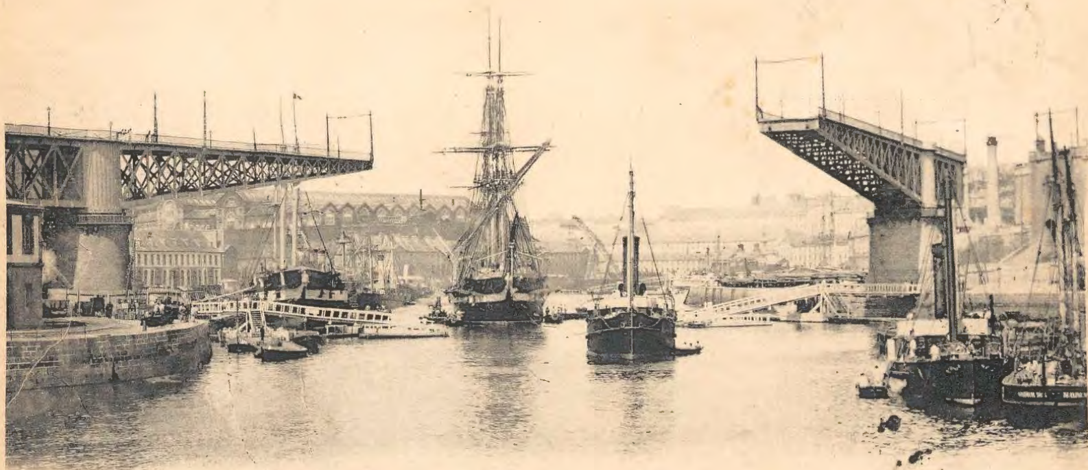
2. — BREST - Le Pont National (ouvert)
