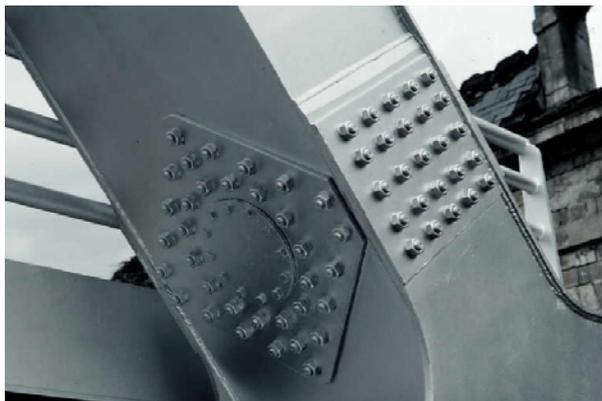
*assemblage par boulons à serrage contrôlé*
