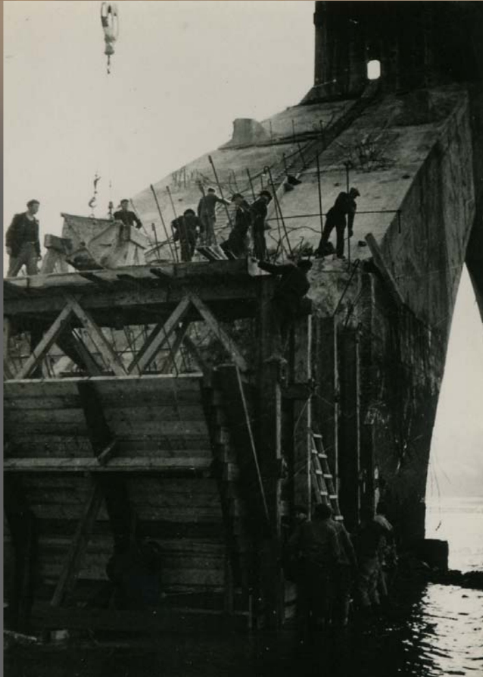
Travaux préparatoires sur pile
