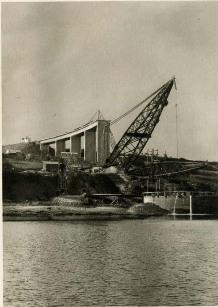
Le Transbordeur. — Levage des pylônes en bois de 55 mètres de hauteur supportant les deux câbles.
