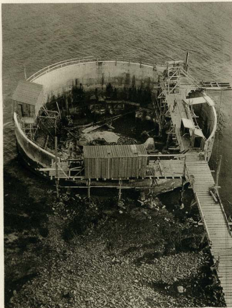
Le batardeau de la culée Brest.
