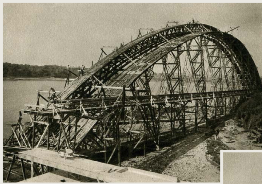
Construction du cintre
