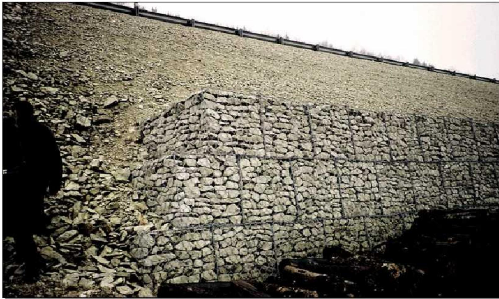
**Ce type de soutènement est perméable**
