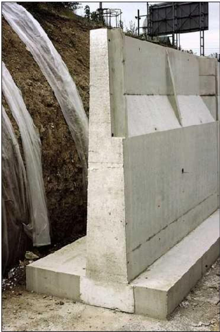
*Mur en béton armé
