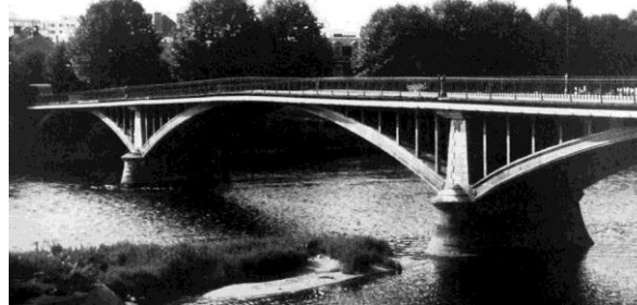
Pont de Châtellerault 1898
