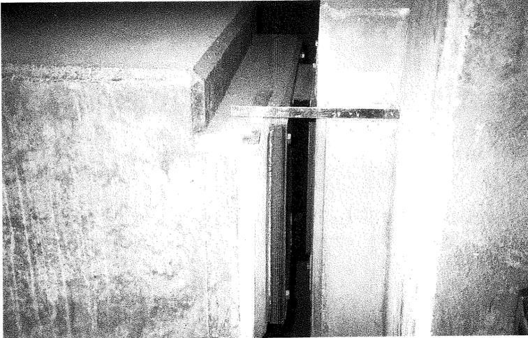
*Figure 2.5 : exemple d'un réglet de suivi de déplacement (appareil d'appui vertical en butée antisismique)*
