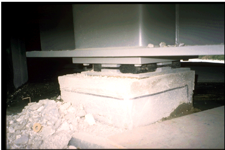
Figure 2.8 : exemple d'un appareil d'appui à distorsion limitée ou bloquée
