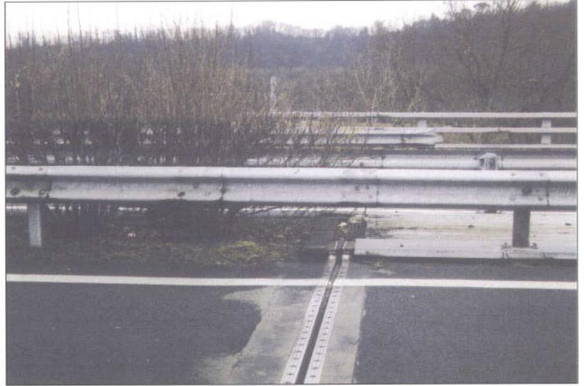
Dans le principe, les dispositions pour les lisses profil A et B sont donc valables jusqu'à 15 cm, mais on peut craindre qu'au delà de 10 cm, le risque d'une poche importante de la barrière soit de nature à entraîner un défaut de comportement, voire un blocage du véhicule.
