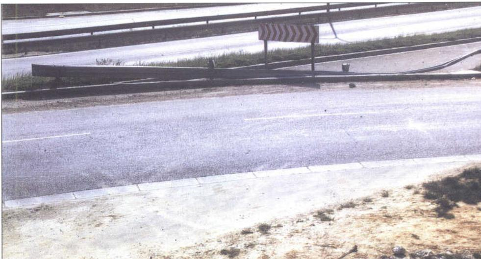
b) Toute disposition qui conduirait à une réduction de cet ancrage d'extrémité (car cette longueur efficace consiste à donner au dispositif un ancrage linéaire) va aussi diminuer cette efficacité. C'est le cas du passage des joints de chaussées par les barrières dont la dilatation est assurée par des trous ovalisés ne permettant la transmission des efforts d'ancrage linéaire qu'en bout de course des trous ovalisés.
