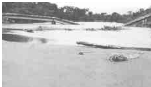
Photo 7 : Exemple de liquéfaction (Costa Rica, 1990)
