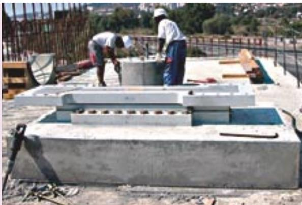
Photo 7 : butée transversale disposée sur la culée C0
