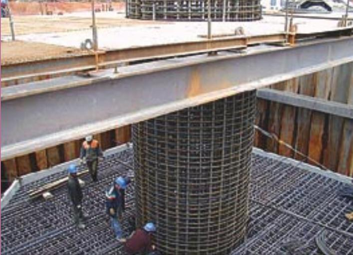
Photo 6 : ferrailage des zones de rotules plastiques (≅ 340 kg/m<sup>3</sup>)
