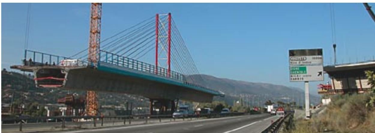
Photo 1a : construction du 1<sup>er</sup> fléau parallèlement à l'autoroute (avant rotation)
