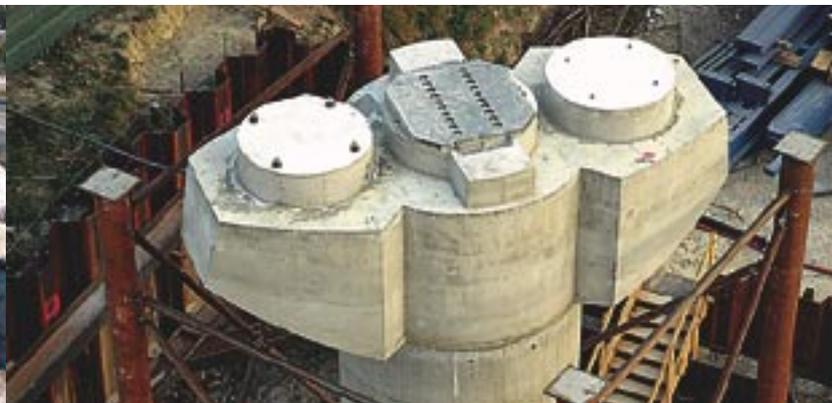
Photo 8 : pile P1, chevêtre et bossage pour butée transversale
