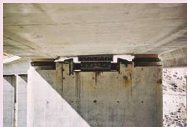
Photo 3 : amortisseurs précontraints transversaux montés sur un pont à Petra Tou Roumiou (Chypre) selon la même disposition que celle proposée pour P2 et P4
