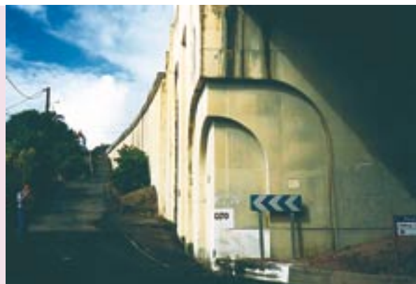
Photo 4 : mur de soutènement côté C_0
