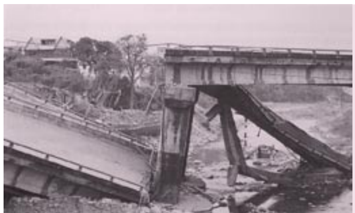
Photo 5 : exemple d'échappement d'appui (Taiwan)
