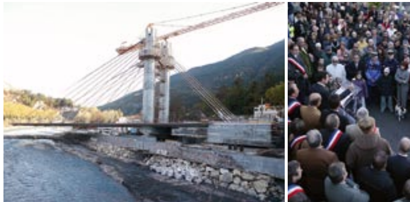
Photos 13 : la rotation de l'ouvrage
