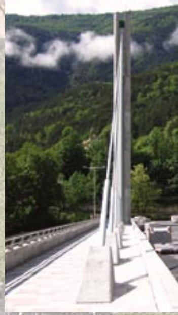
c) dallage des trottoirs
