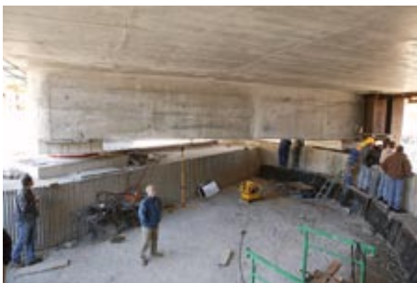
a) vue générale
