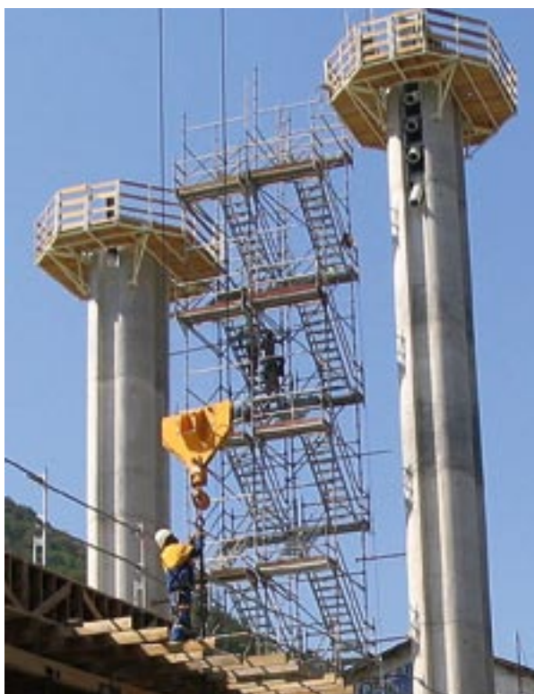
a) échafaudage général
