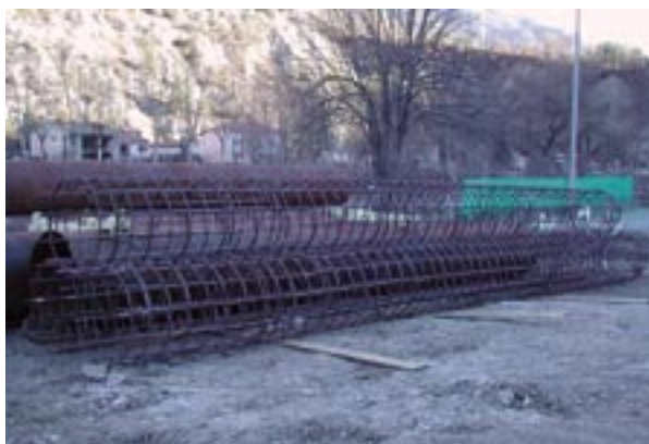
a) cages d'armatures
