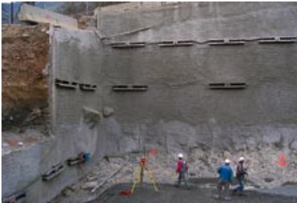
a) fouille et terrassement (mars 2004)
