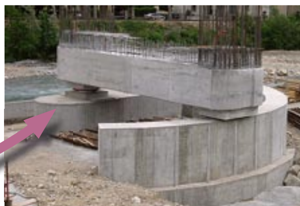
Photos 4 : positionnement de l'entretoise sous pylône avant rotation et détail de la couronne de guidage
