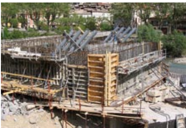
a) coffrage et ferrailage (mai 2004)
