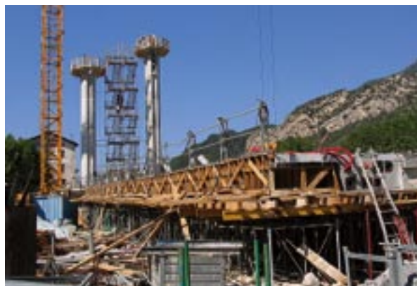
a) vue générale du cintre et plaques d'ancrage de la précontrainte
