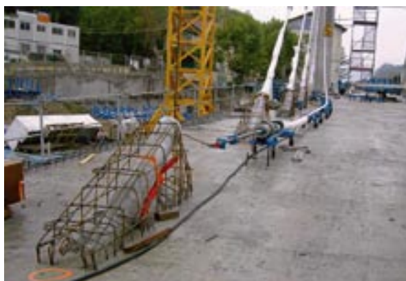
Photos 12 : mise en tension des haubans avant rotation depuis la sous-face du tablier
