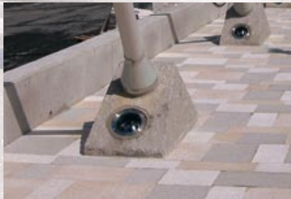
f) spots d'éclairage des haubans de retenue
