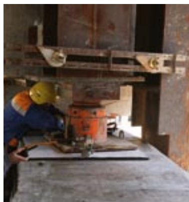
b) pesée de la réaction d'appui sous la béquille arrière de stabilisation
