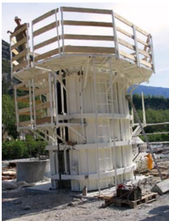
b) coffrage grimpant des levées de 4 m
