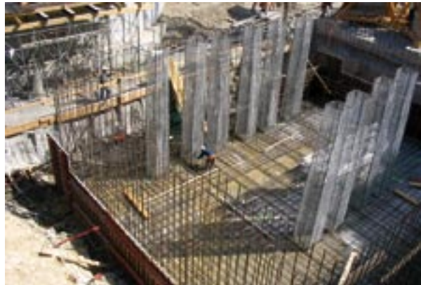
b) ferrailage et réservations pour les cheminées de solidarisation (mai 2004)
