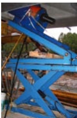
Photos 12 : mise en tension des haubans avant rotation depuis la sous-face du tablier
