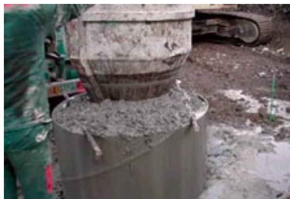
b) gaine métallique et bétonnage
