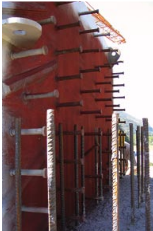
Photos 10 : boîtes d'ancrage métalliques des haubans
