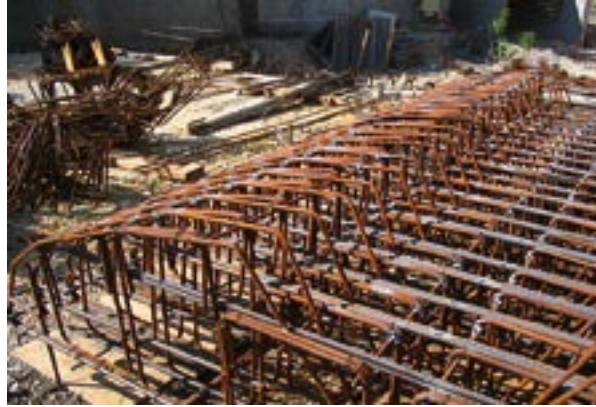
Photo 9 : cage d'armature d'une levée de pylône (ratio d'acier : 137 kg/m 3 )
