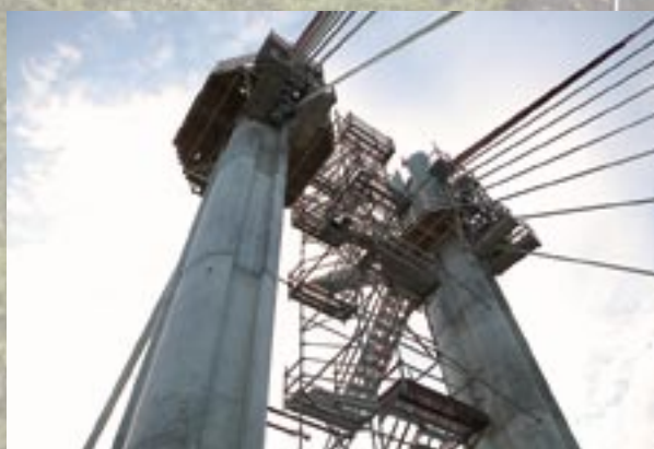
Photos 16 : réglage définitif des haubans depuis les têtes de mâts
