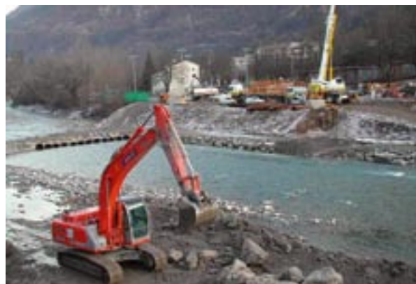
Photo 2 : travaux de terrassement généraux (sept. 2003)
