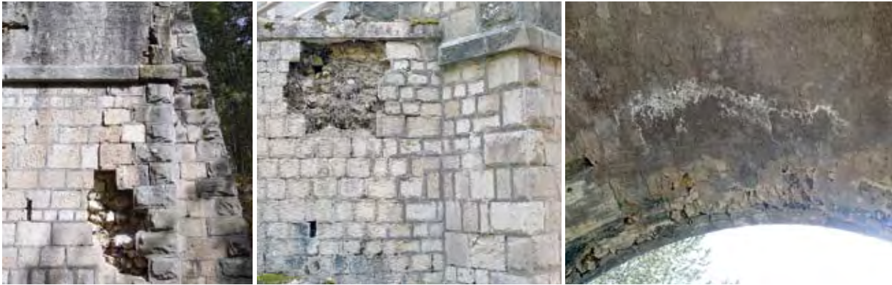
Figure 13 : pont en maçonnerie SS80 km 20 – Source : Sétra
