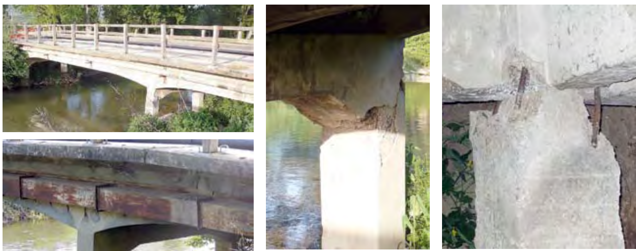
Figure 16 : pont d'Onna (tablier, piles et culées) – Source : CETE Méditerranée, Sétra
