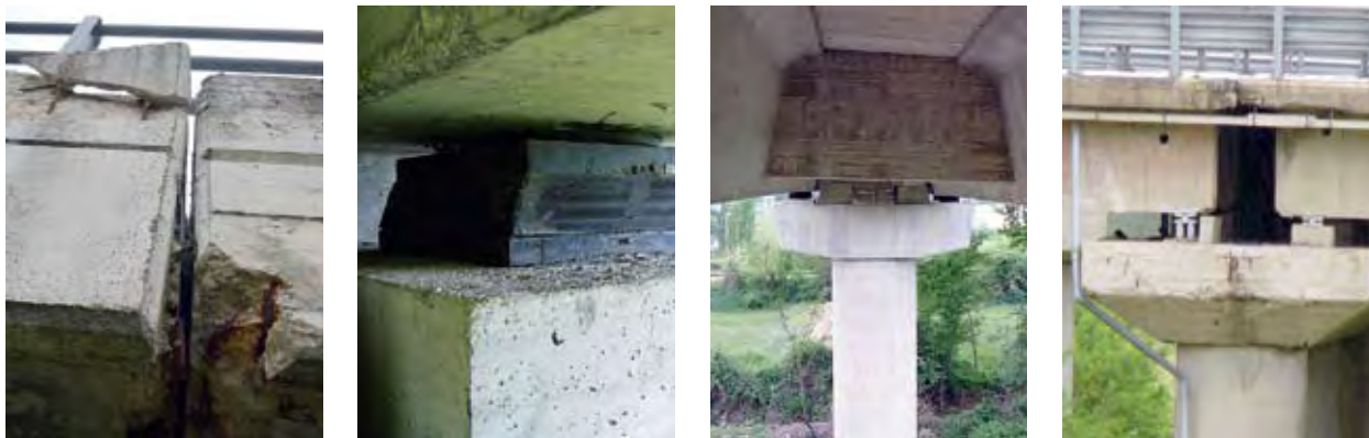
Figure 11 : pont de la bretelle de l'échangeur de l'Aquila ouest A24 Pont 11 (à gauche) Pont 12 (à droite) – Source : CETE Méditerranée, Sétra
