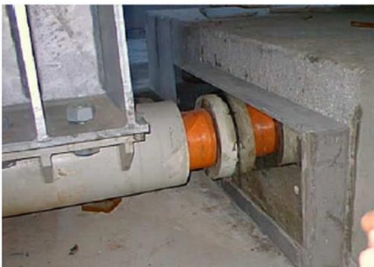
Figure 16 : Exemples de dispositifs amortisseurs à ressort précontraint
