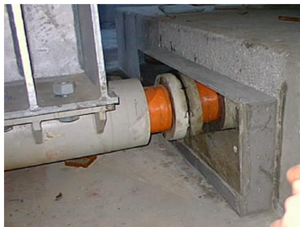
Dispositifs amortisseurs précontraints disposés transversalement sur piles - sources Jarret
