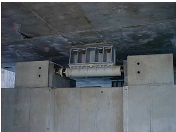
Dispositifs amortisseurs précontraints disposés transversalement sur piles - sources Jarret
