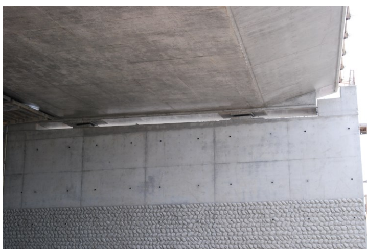
Figure 5 : Vue des butées parasismiques transversales de l'OA19 (source : Cerema / DTerMed)
