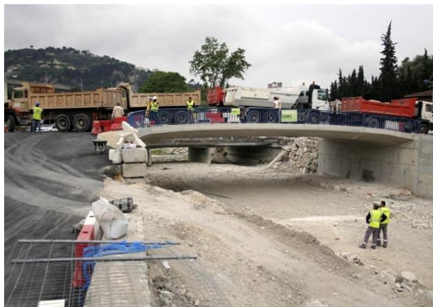
Figure 1 : Vue générale du pont de St-André La Roche (source : Cerema / DTerMed)
