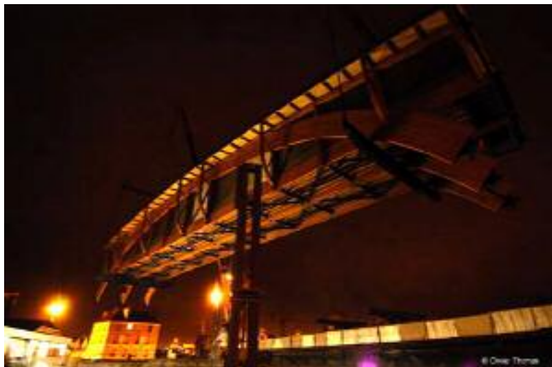
Photo 2 : passerelle de Vaires-sur-Marne conçue par SNCF Ingénierie – Bernard Rey architecte. ( photo Olivier Thomas )
