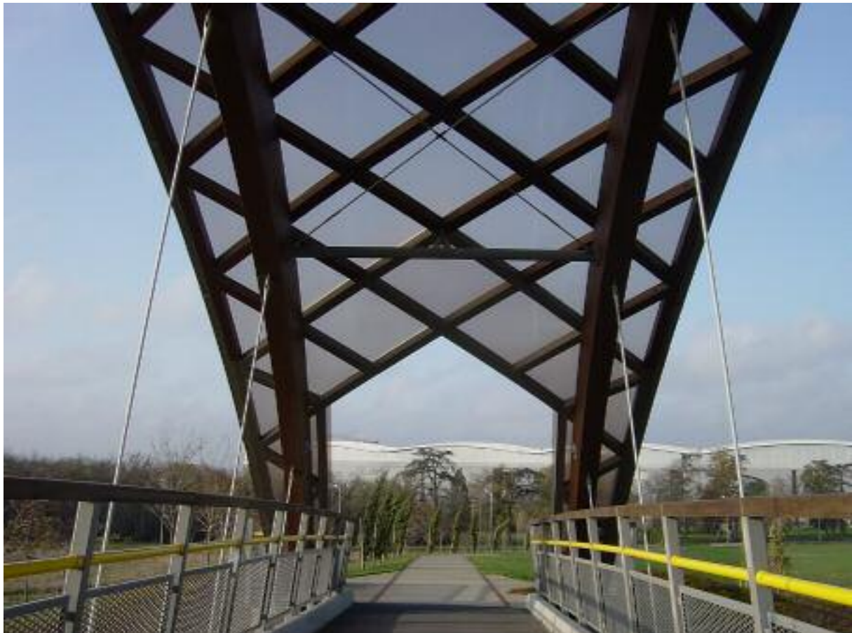
Photo 7: Vue intérieure de la passerelle Pinot, de 36m de portée. Les arcs sont en bois, les tirants et suspentes en acier et la dalle en béton.
