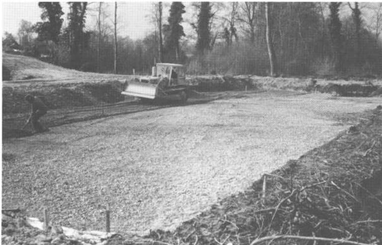
Figure 6.6 - Réalisation d'une fondation artificielle
