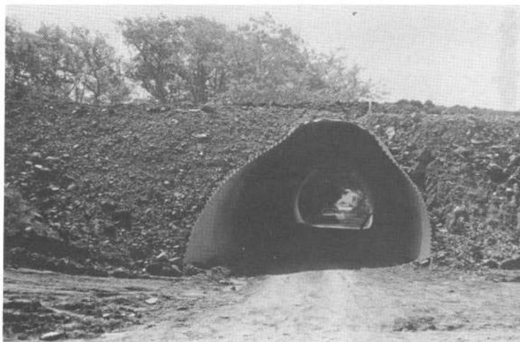
Figure 7.14 - Extrémité déformée en poire
