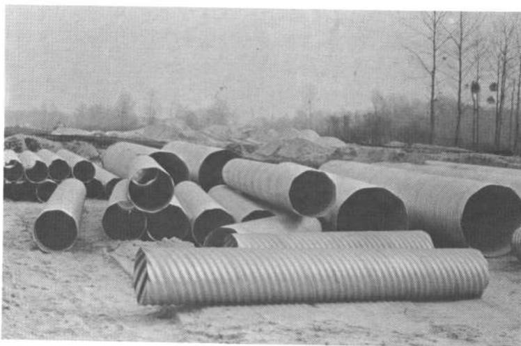
Figure 2.12 - Joint en hélice agrafé par pliage (SPIWELL)
