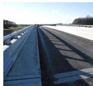
Barrière béton
