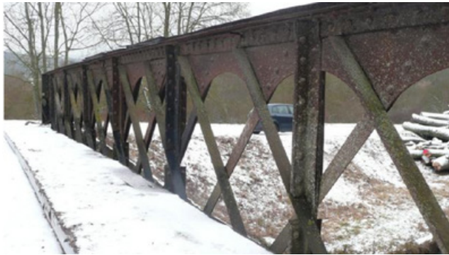
Avant 1900 – Fer puddlé, rivets
