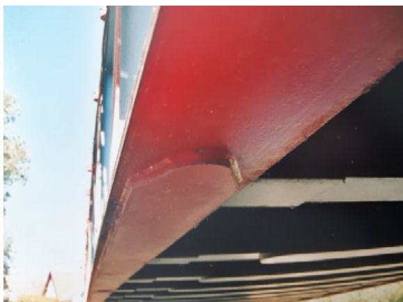
1960 – semelle additionnelle non délardée
