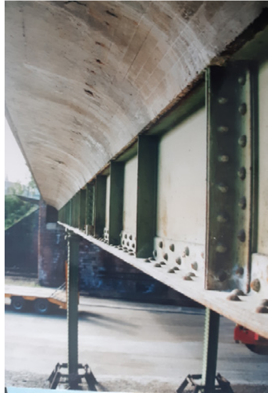
1937 – hourdis en béton mince, piles métalliques très fines
