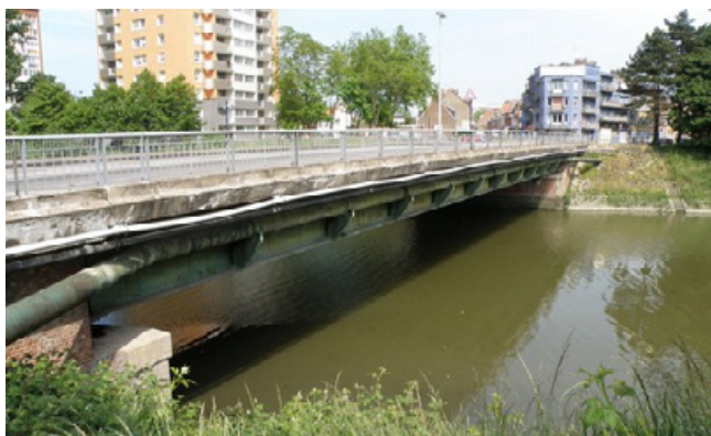
Les appuis de l'ouvrage sont partiellement visibles depuis les berges du canal.
