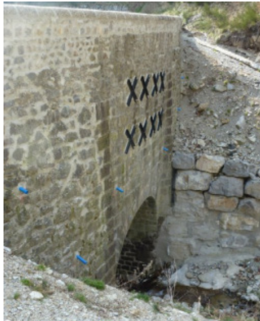
Réparation du mur tympan d'un pont voûte en maçonnerie par tirants
