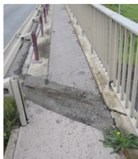
Glissière de sécurité
