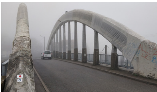
1926 – suspentes et pièces de pont fines
