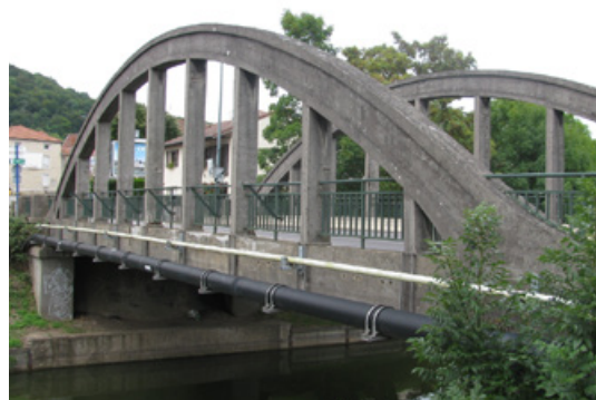
1953 - suspentes et pièces de pont plus épaisses
