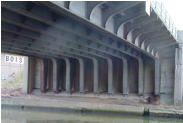
1946 – bacs en acier coffrant le béton
