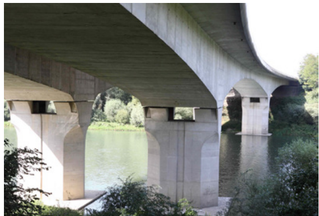
1977 – pont caisson en béton précontraint
