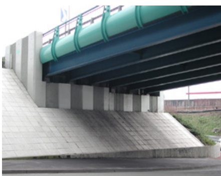
Exemple de culées avec talus ou perré
