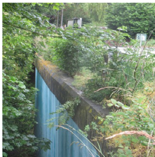
Le parement du mur est partiellement visible ; pas d'accès en contrebas et partie supérieure encombrée de végétation.
