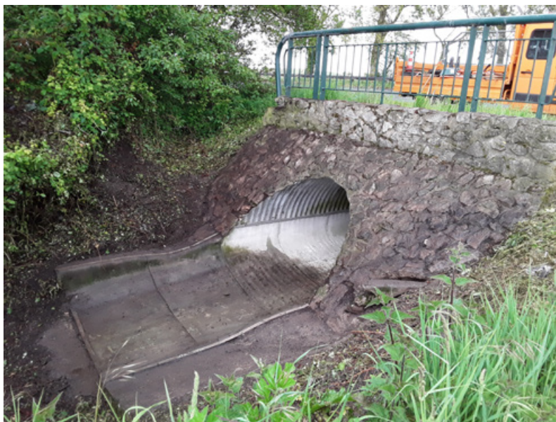
Travaux de dévégétalisation
