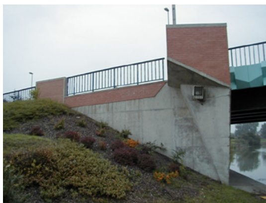
Exemples de culées avec mur de front
