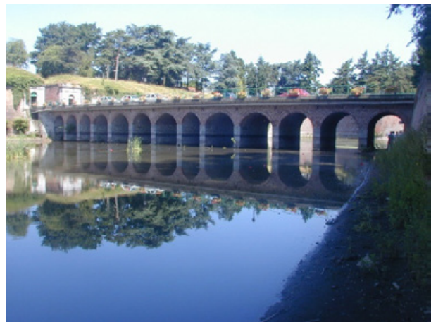
Pont en maçonnerie à arches multiples
