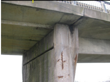
Exemple de pile-culées
