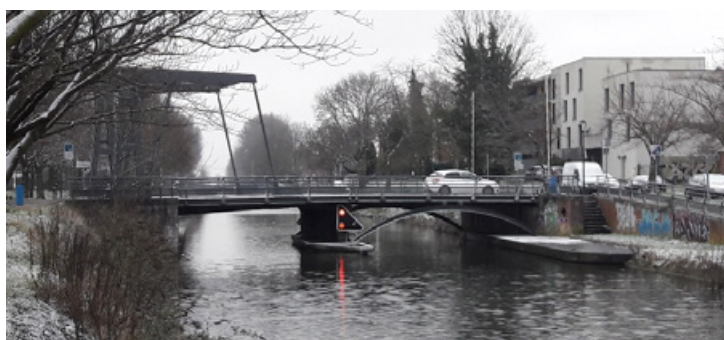
Cas d'un pont mobile contigu à un pont fixe (à recenser séparément)
