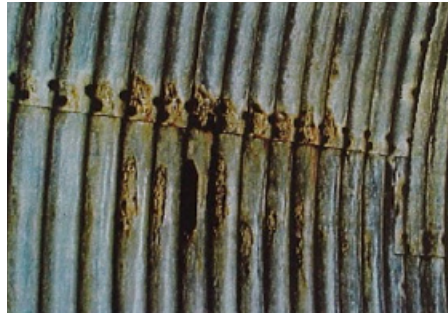
Corrosion localisée
