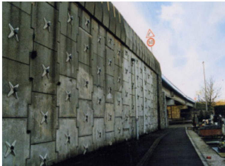
Réparation d'un mur par clouage
