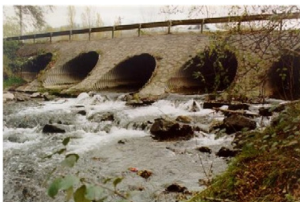
Exemple de buse multiple
