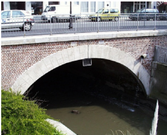
Voûte en maçonnerie à arche unique
