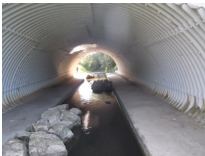
Réparation d'une buse métallique par un radier en béton armé
