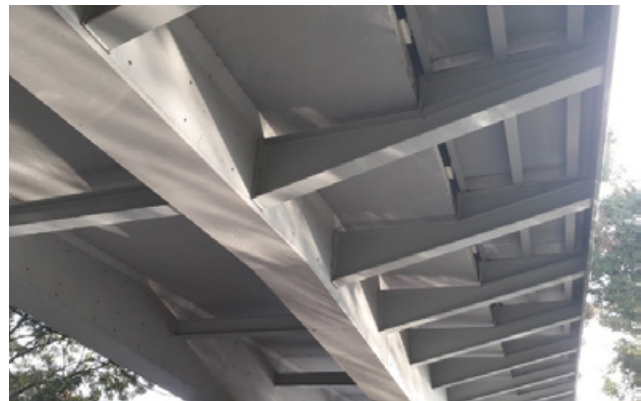
Élargissement d'un tablier à poutres en béton précontraint par un encorbellement métallique sur consoles
