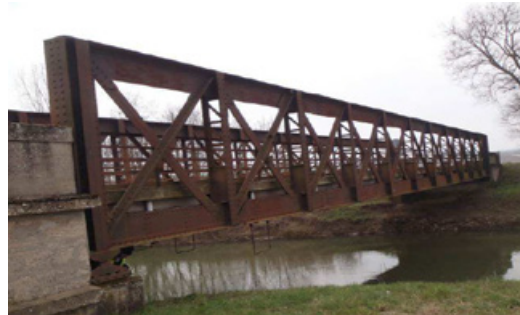
1954 – Aciers doux, rivets, hourdis béton armé
