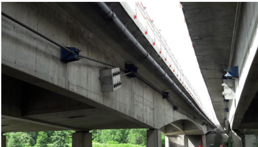
Pont à poutres réparé par précontrainte extérieure additionnelle
