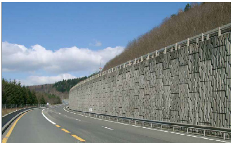
Exemple de mur en terre armée
