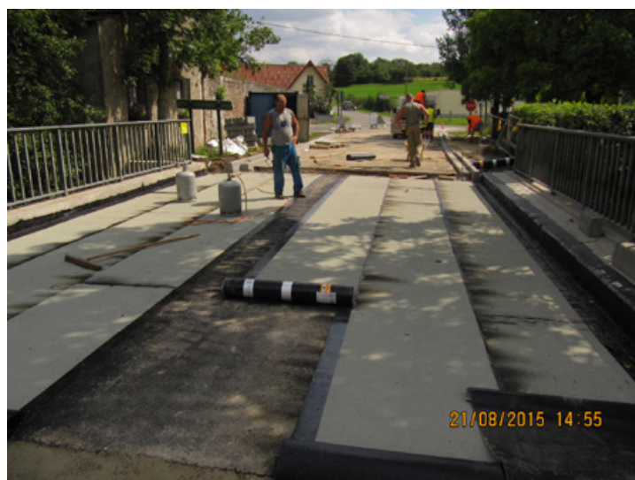
Travaux de réfection d'étanchéité
