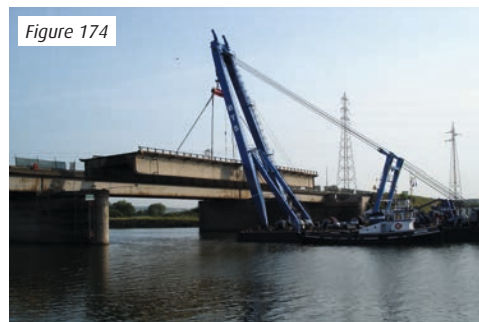
Figure 174 : Colis (travée) levé par la bigue. Recul et début du trajet jusqu'au portique de dépose
