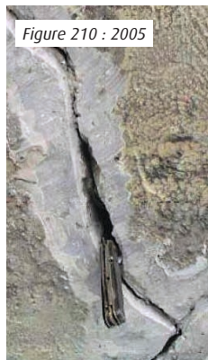
Figures 209-210 : Photos des pathologies – Pylône Rive Gauche : évolution des fissurations
