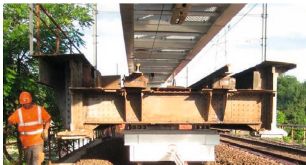
Figure 190 : Pose du tablier sur les lorrys
