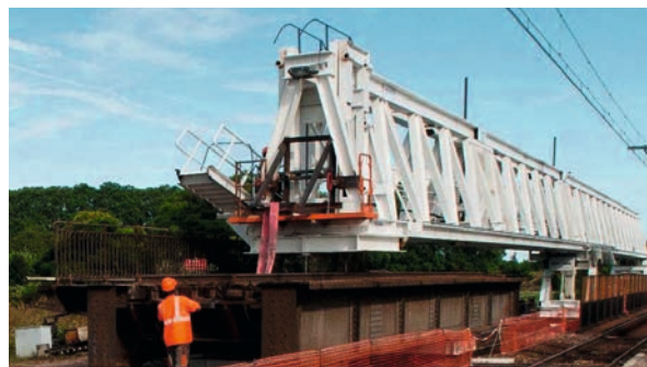
Figure 191 : Sortie du tablier. Le lanceur ne porte alors que sur la palée arrière et centrale
