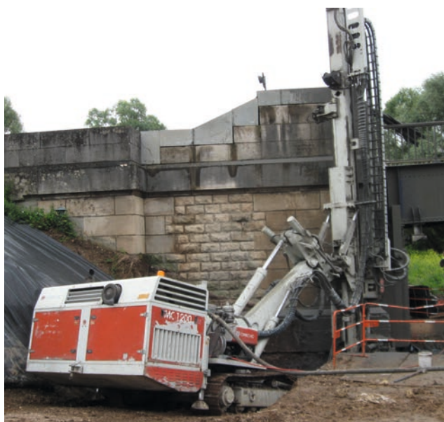
Figure 77 : Rapilly (CG57-2013). Renfort des fondations des culées par micropieux (liaisonnés). NB : ces injections se font en sous-œuvre, en temps masqué alors que le tablier de l'ancien pont est encore en place
