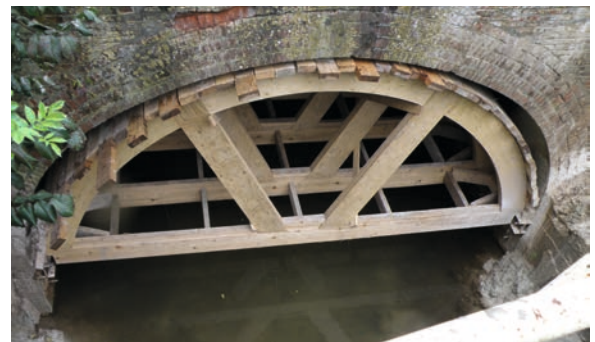
Figure 242 : Cintre pour démolition du pont de Gercy
