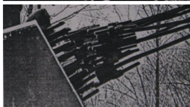
Figure 205 : Découpe des câbles (oxyacétylage) au niveau des massifs d'ancrages des câbles
