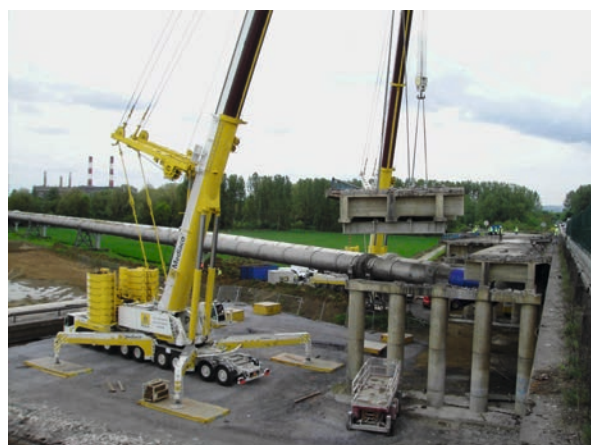
Figure 106 : Grue sur roues. Ces grues ont le grand avantage de pouvoir circuler sur les routes, c'est à dire qu'elles respectent le poids de 13,5 t à l'essieu (les contrepoids sont véhiculés à part). Ici, grue « 700 », de capacité 700 t à 3 m (avec contrepoids de 140 t), 9 essieux
