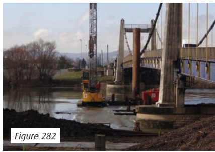
Figure 282 : Demi remblai jusqu'à mi-travée, situation normale
