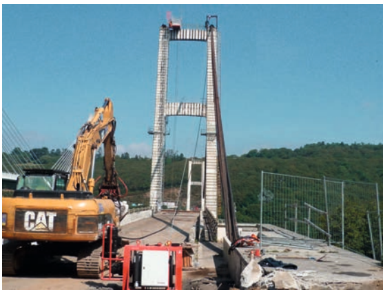
Figure 234 : Dépose des câbles porteurs
