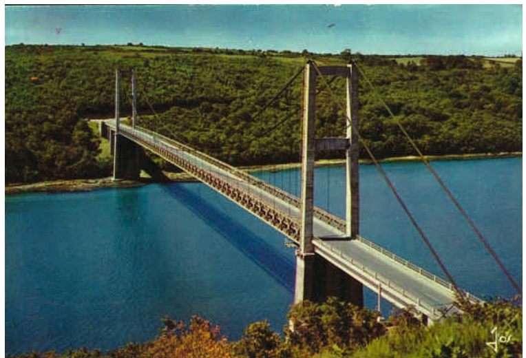
Figure 208 : Second ouvrage reconstruit en 1952 – Pont suspendu (démoli en 2014)
