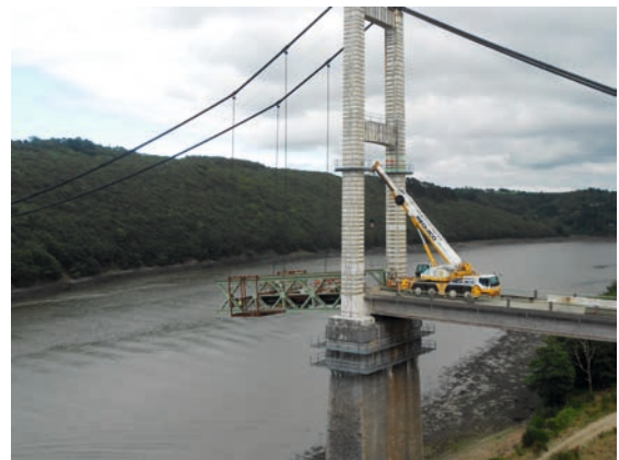
Figure 233 : Démontage – Travée centrale
