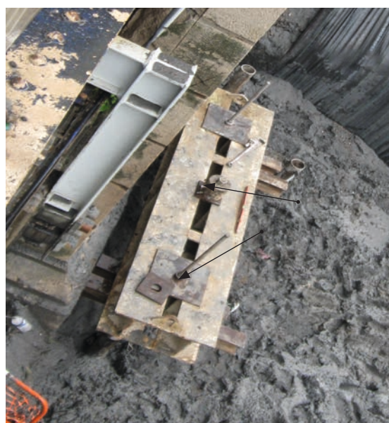
Figure 78 : Rapilly (CG57-2013). Essais de traction de contrôle des micropieux. Le pieu central est testé (cf. le vérin) en frottement latéral. Le massif de réaction est constitué des deux pieux adjacents
