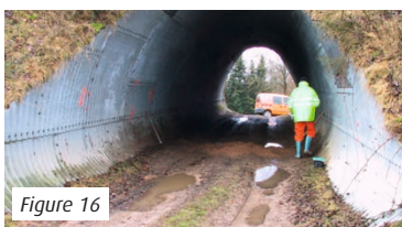
Figure 16 Les buses métalliques sont constituées d'éléments de tôles assemblés par boulonnage. Portée : de 2 à 8 m (rarement plus)
