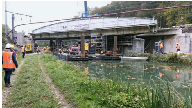
Figure 109 : Enlèvement par barge d'un tablier
