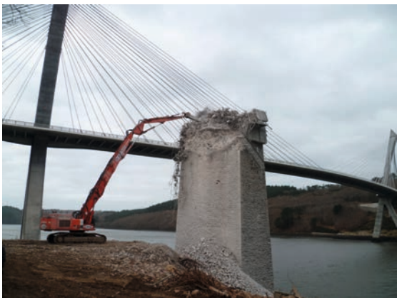
Figure 238 : Démolition des piles
