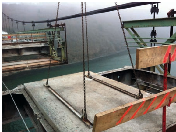
Figure 227 : Levage et dépose dalle béton – Travée centrale
