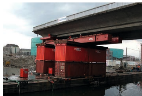
Figure 144 : Délancement du pont Churchill
