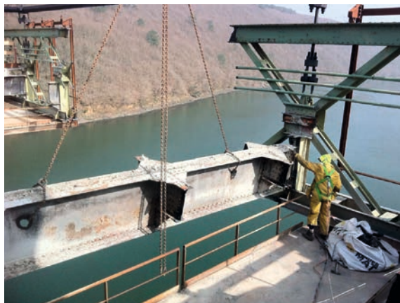
Figure 228 : Découpage et levage des longerons – Travée centrale
