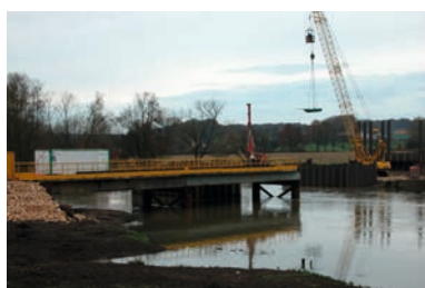
Figure 280 : Ponton d'accès provisoire (impact minimisé sur les milieux aquatiques et sur l'hydraulique)
