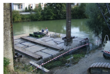
Figure 281 : Plateforme flottante (caissons assemblés) sur appuis à fonder : permet l'accès et le travail d'engins (impact minimisé sur les milieux aquatiques et sur l'hydraulique)
