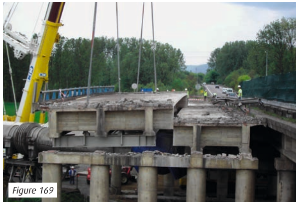
Figures 169-170 : Grutage par paquet de poutres VIPP de Richemont
