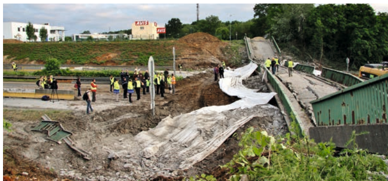
Figure 258 : Samedi 2012:06:23 06:32:44 Vue en long du pont avec le remblai de protection de chaussée
