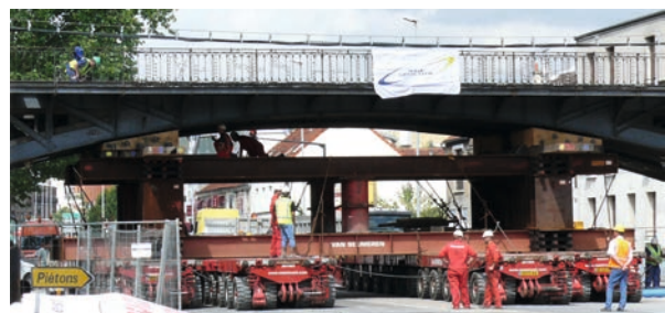
Figure 112 : Pont RN 1 / tramway Saint Denis-Sarcelles à Pierrefitte-sur-Seine. Enlèvement de l'ancien pont (650 t) au moyen de 4 Kamags de 48 roues chacun. Pose du nouveau pont (1 000 t plus large et long), interruption de la RN1 pendant 4 jours, la pose du nouveau pont ne prenant que 1 nuit
