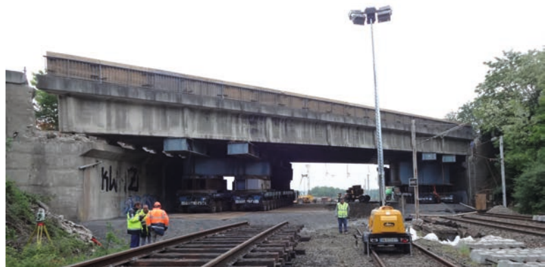
Figure 143 : Rosbruck - enlèvement par porteur multi-essieux pendulaires
