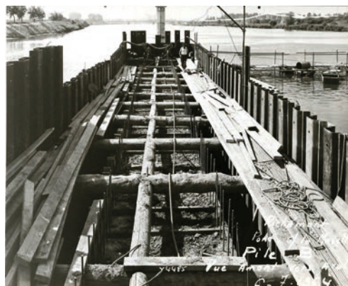
Figure 71 : Photo lors de la construction d'une pile en 1964
