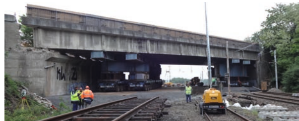
Figure 177 : Vue du tablier en cours déplacement par les porteurs multi-essieux
