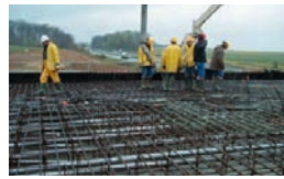
Figure 33 : Bétonnage + vue des câbles
