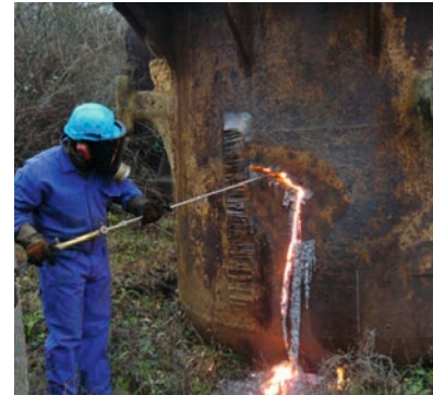
Figure 138 : Découpe par chalumeau d'oxycoupage. © Ent. ARCEMOLITION
