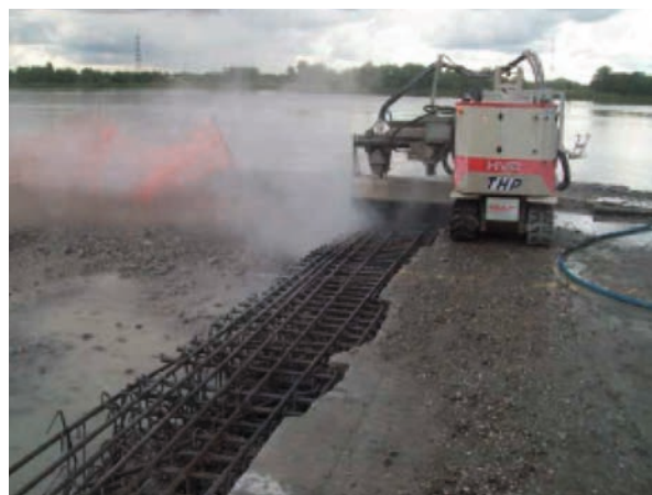
Figure 120 : machine d'hydrodémolition
