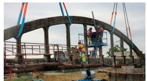
Figure 171 : Mise en place de la scie pour sciage biais en 2 1/2 travées de la poutre-arc
