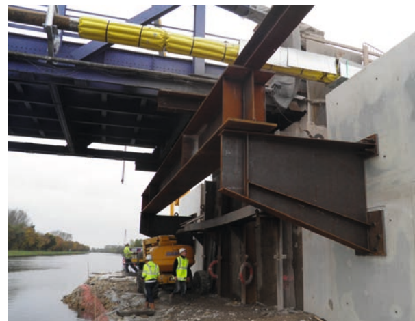
Figure 265 : NB : Appui provisoire du tablier à l'avant de sa ligne d'appui définitive le temps de démolir la culée fracturée
