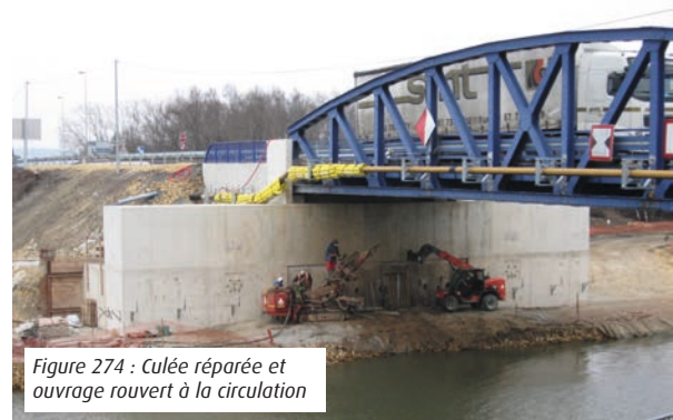
Vue de la culée réparée
