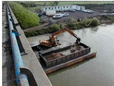
Figure 291 : Dragage préalable à l'amenée d'une bigue fluviale
