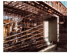
Figure 38 : Vue câblage et ferrailage poutre
