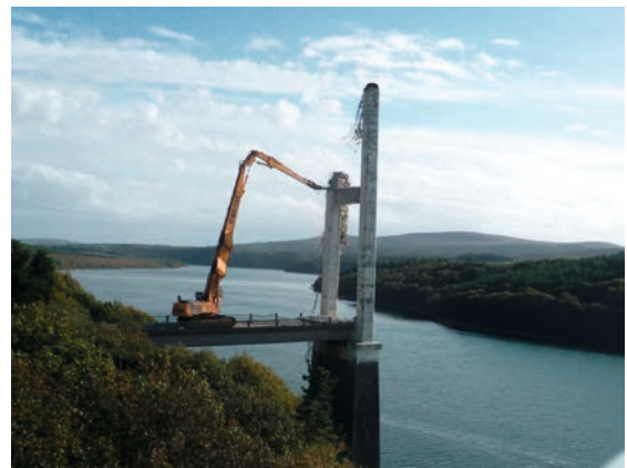
Figure 235 : Démolition des pylônes
