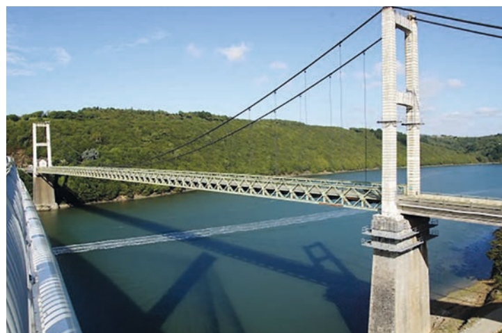
Figure 223 : Vue générale de l'ouvrage avant travaux
