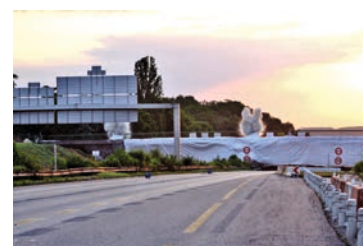
Figure. 147 : Démolition à l'explosif d'un pont sur l'A10 (Dirif)
