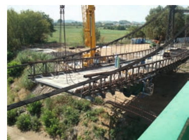
Figure 146 : Démolition du pont Pailhes (CG30)
