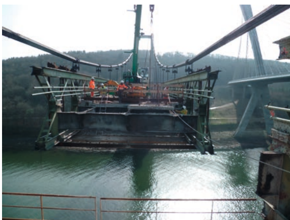
Figure 230 : Levage dalle béton – Travée centrale
