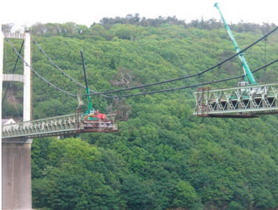
Figure 232 : Démontage – Travée centrale
