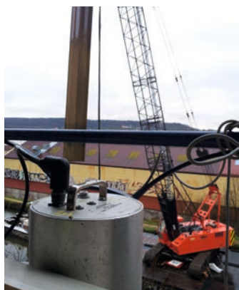
Figure 102 : Réalisation de planches d'essai d'un vibreur lors de la réalisation de mur soutènement à proximité d'habitations
