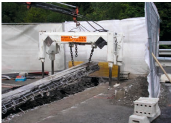
Figure 278 : Hydrodémolition de bord de dalle
