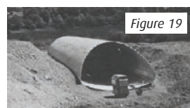
Figure 19 Remblaiement - compactage (NB : engins adaptés à proximité)
