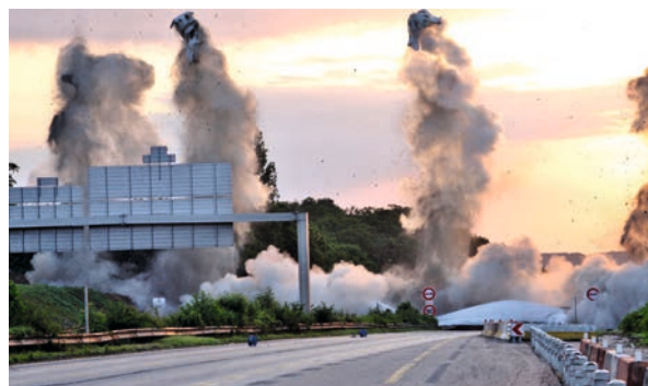
Figure 256 : Samedi 2012:06:23 -06:12:33 Vue du pont (plus visible) quelques secondes après minage
