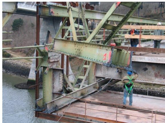
Figure 229 : Levage poutre de rives – Travée centrale
