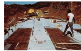
Figure 41 : Réalisation du hourdis
