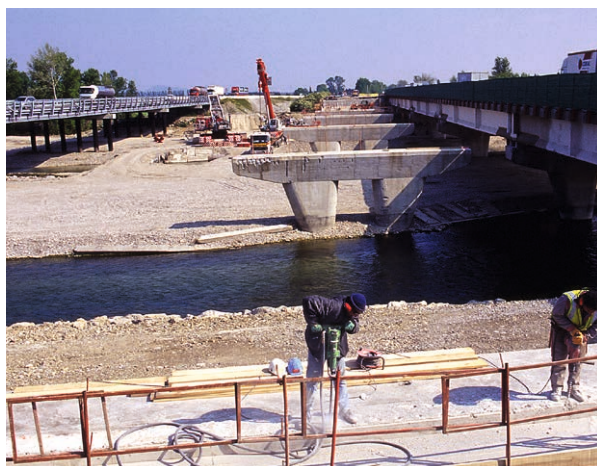
Figure 201 : Vue de l'ossature métallique du nouveau tablier mixte
