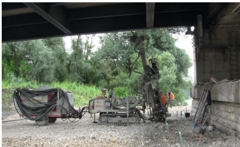
Figure 76 : Rapilly (CG57-2013). Renfort des fondations de pile par injection. NB : ces injections se font en sous-œuvre, en temps masqué alors que le tablier de l'ancien pont est encore en place
