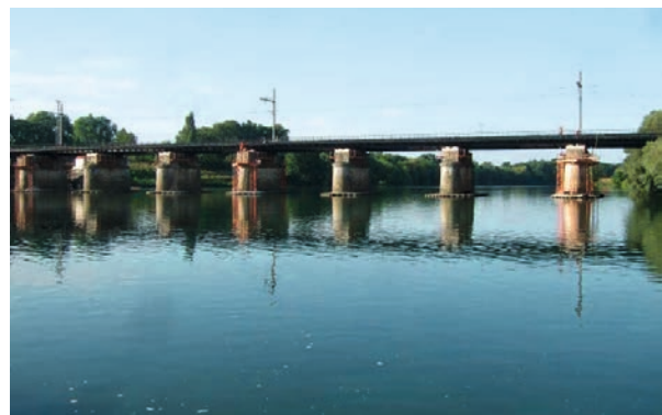
Figure 181 : Vue longitudinale (étiage)
