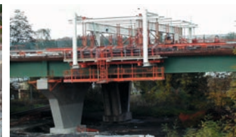
Figure 53 : Équipage mobile pour coulage dalle par plot
