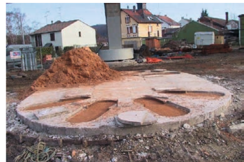
Figure 165 : Vue du socle des piles (avec niches de vérinage)
