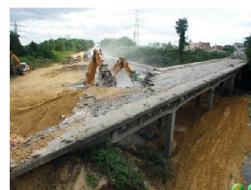
Figure 145 : Démolition d'un pont à Massy en 2009 (CG91)
