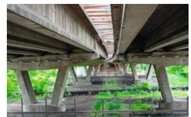
Figure 148 : VIPP Merlebach - vue générale des 2 tabliers
