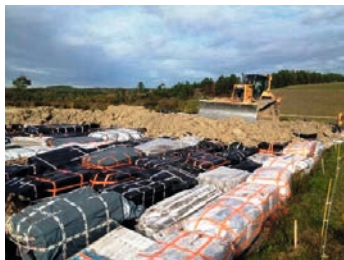
Figure 93 : Acheminement et manutention - Centre d'Enfouissement Technique dédié à l'Amiante lié de Lannemezan.- site internet de l'ent. PSI
