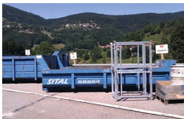
Figure 301 : Bennes de tri des déchets de chantier
