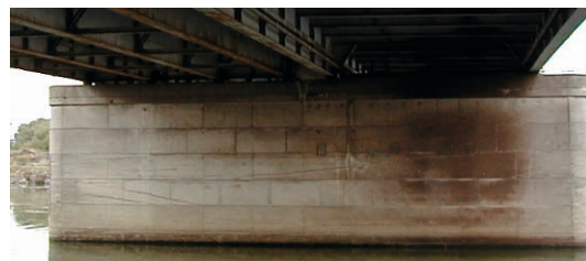
Figure 69 : Pile Dalle orthotrope (pont principal). La pile est un voile commun au sens + et -. On comprend qu'il n'est pas envisageable de faire une autre pile juste pour le sens +, et ce dans le lit mineur et navigué de la Moselle. Les piles sont en bon état.
