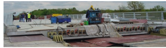
Figure 32 : Vues de têtes d'ancrage et du système de vérins de poussage
