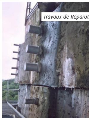
Figure 211 : Renforcement par corseutage de tirants précontraints en 2000
