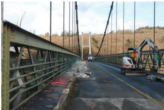
Figure 224 : Dépose des bordures et robotage chaussée
