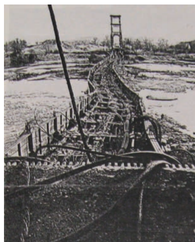
Figure 206 : Effondrement général du pont. Découpe et évacuation des matériaux de démolition dans le lit (mineur et majeur) de la rivière
