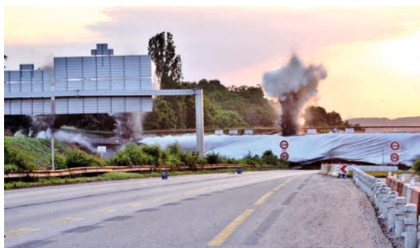
Figure 255 : Samedi 2012:06:23 -06:12:15 Démolition à l'explosif des piles, vue des protections
