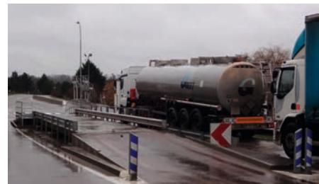
Figure 95 : Entrée et contrôle des camions (contrôle visuel et administratif CAP, BSDA, scellés ; pesage PL, test contrôle lixiviat ; pour l'amiante pesage et vérification des différents colis correspondant aux différents BSDA) - ISDD de Drambon (site de SITA-FD)
