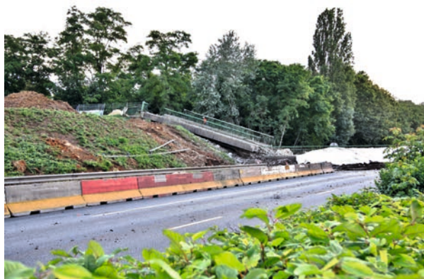
Figure 257 : Samedi 2012:06:23-06:12:33 Vue du pont abattu, inspection avant réduction + évacuation
