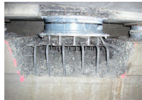
Figure 275 : Hydrodémolition d'un déd d'appui
