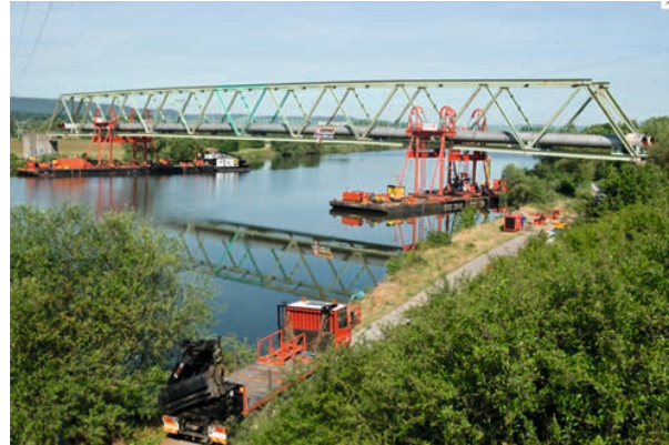
Figure 176 : Mise en place des barges équipées de portiques avec traverses levées par vérins à câbles. Traverses hautes, l'ouvrage est soulevé et déplacé de ses appuis
