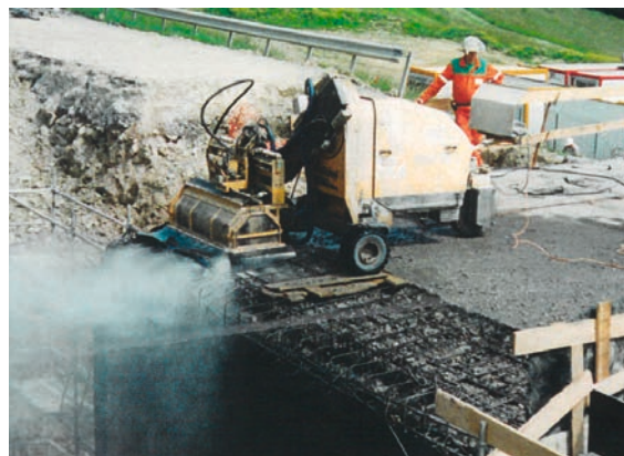
Figure 279 : Hydrodémolition de solin de joint de chaussée
