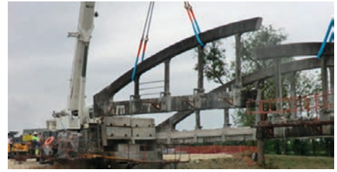
Figure 172 : Grutage du 1 er demi arc
