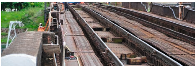
Figure 179 : Vue du dessus des voies et de l'intrados
