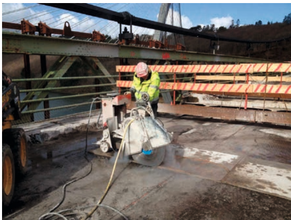
Figure 226 : Sciage de la dalle béton – Travée centrale
