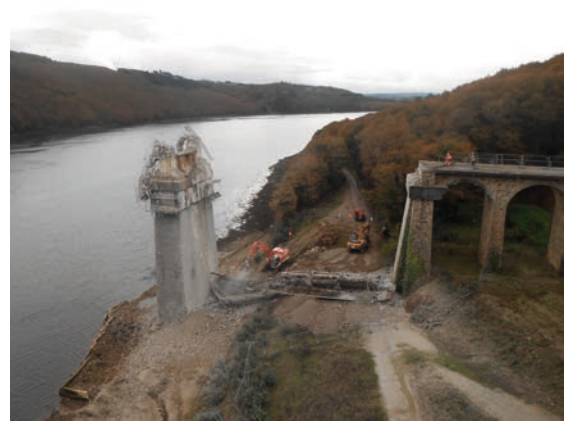
Figure 237 : Démolition des travées d'accès en BA
