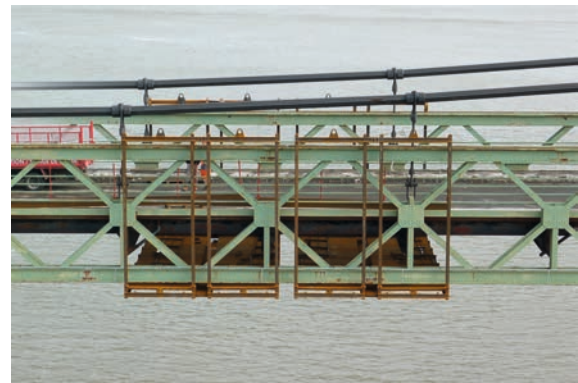
Figure 225 : Fixation des nacelles de sécurité sous ouvrage
