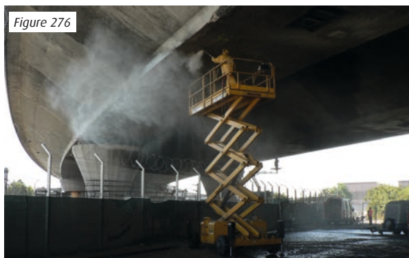
Figures 276-277 : Hydrodémolition viaduc de Drancy
