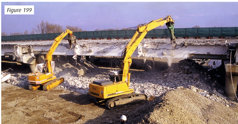
Figures 199-200 : Deux croc'béton démolissent symétriquement la poutre par le dessus. Un coup de pince au niveau des ancrages des câbles de 2 e famille est appliqué. Puis ils détruisent et éliminent le béton de l'âme sur la longueur de poutre (en remontant à partir des entretoises intermédiaires pour suivre le tracé des câbles). Enfin, ils démolissent les entretoises et attaquent les câbles d'extrémités jusqu'au « pliage » accompagné de la poutre. À ce stade, les croc'béton éliminent les entretoises qui liaient cette poutre à la suivante. Ensuite, un croc'béton détruit le milieu de poutre. Quand il arrive au talon, la poutre commence à se ruiner et à fléchir, et il peut alors, d'un coup à l'horizontale vers l'arrière, la tirer pour la dégager de l'appui
