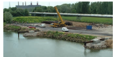
Figure 292 : Berges remblayées et création d'un ponton d'accostage pour la bigue, et la dépose des tronçons d'ouvrage démoli
