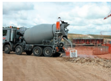
Figure 288 : Aménagement d'aire de lavage des toupies (lavage « sauvage » dans les cours d'eau strictement interdit)
