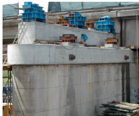
Figure 75 : Pile-culée. La tête de pile a été démolie et refaite à partir du haut du fût. Nota : les camarteaux en attente.
