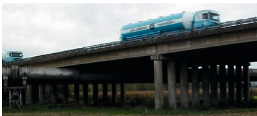
Figure 70 : Pile VIPP d'accès. (Lit majeur d'inondation de la Moselle). On note la présence du double gazoduc (gaz CO). Les piles sens + et sens- sont séparées. Les piles sont en bon état si ce n'est que le chevêtre ne fait que 50 cm de haut et ne permet aucun appui latéral. Chaque poutre est à l'aplomb d'un fût.
