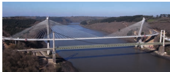
Figure 213 : Nouveau et Ancien Pont de Térénez en 2011
