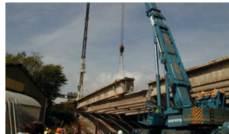
Figure 142 : Merlebach, grutage d'une poutre de VIPP
