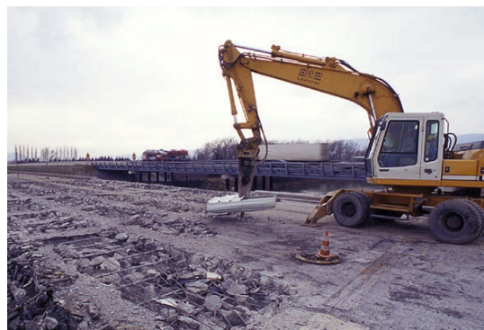
Figure 196 : Démolition du hourdis entre poutres au BRH par-dessus l'ouvrage en reculant. Les entretoises (d'about et intermédiaires) sont conservées
