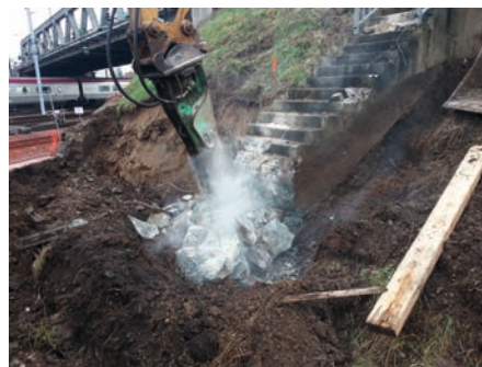
Figure 104 : Suivi vibratoire d'équipement et de structures SNCF lors de la démolition d'ouvrage
