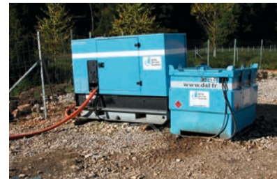
Figure 284 : Nécessité de prévoir un bac de rétention étanche sous le groupe électrogène pour éviter une pollution des sols par hydrocarbure lors du remplissage du réservoir
