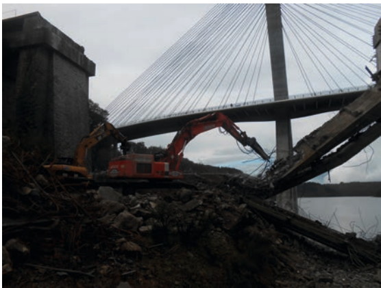
Figure 236 : Démolition des travées d'accès en BA
