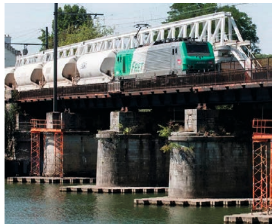
Figure 185 : Vue du lanceur (depuis l'arrière) sous circulation
