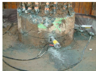
Figure 124 : Recépage démolition par éclateur d'une tête de pieu (ph. ent. Durmeyer)
