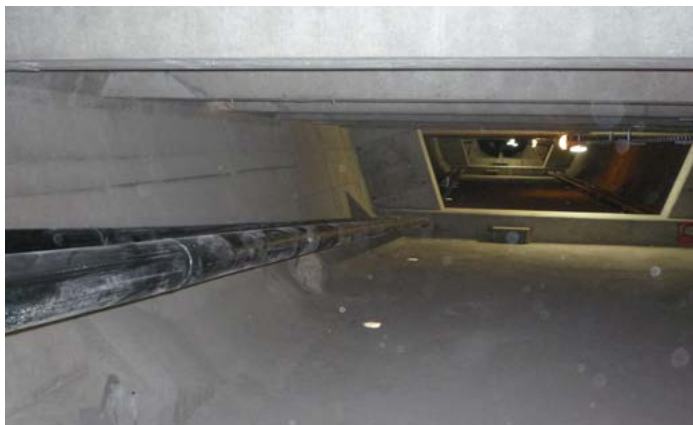
Figure 35 : Précontrainte additionnelle à l'intérieur d'un caisson
