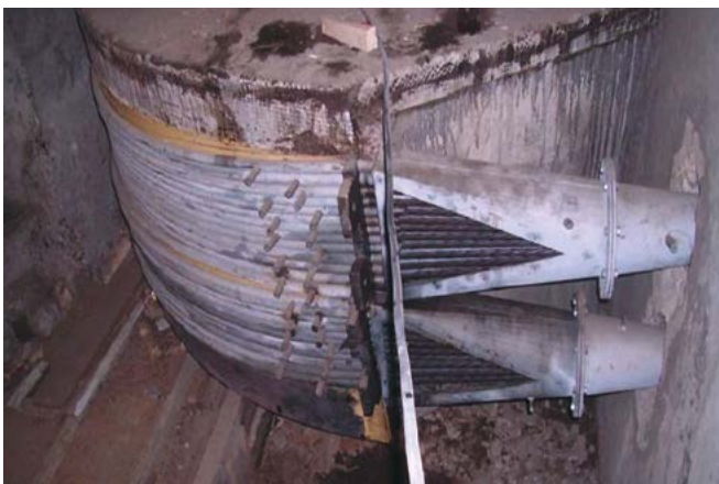
Figure 26 : Réparation du viaduc de Saint-Cloud
