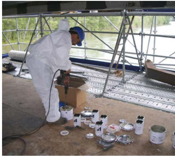
Figure 12 : Mélange de l'adhésif bi-composant (résine et durcisseur)
