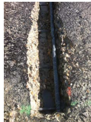
Figure 7 : Exemple d'ajout d'armatures passives pour réparation locale
