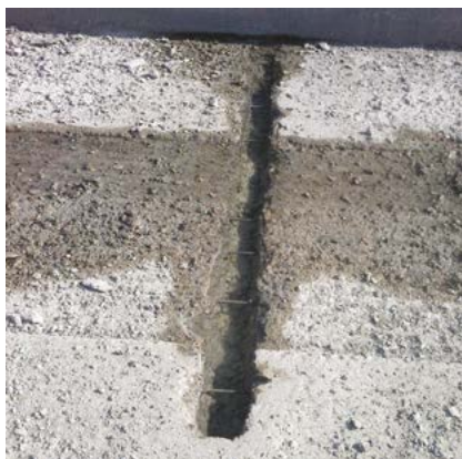
Figure 7 : Exemple d'ajout d'armatures passives pour réparation locale
