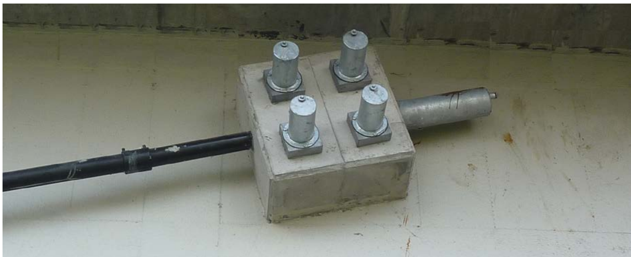
Figure 24 : Ancrage de câble additionnel sur un bossage
