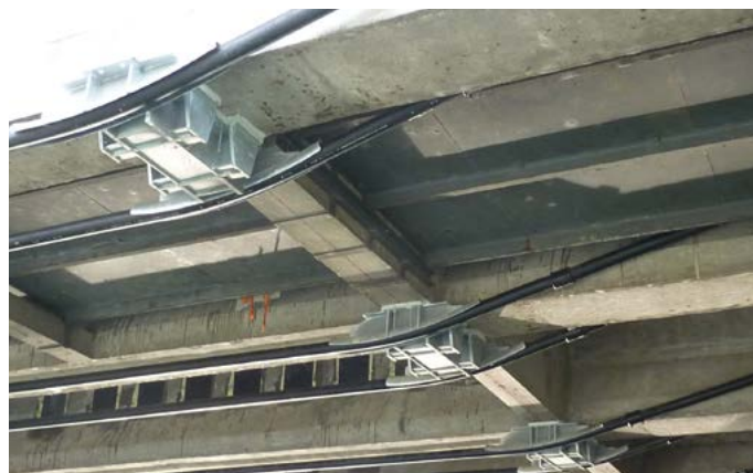
Figure 31 : Précontrainte légèrement intradossée
