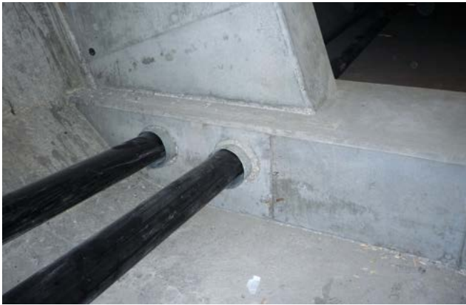
Figure 28 : Déviateur en béton
