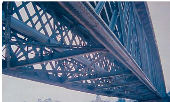
Figure 56 : Exemple du renforcement du pont de Douarnenez (voir détail figure ci-dessous) par profilés métalliques soudés en sous face de la membrure inférieure
