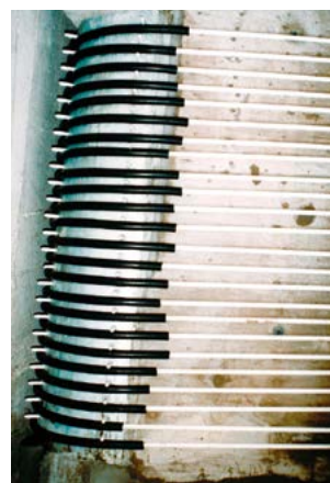
Figure 27 : Réparation du pont de S.
