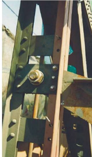
Figure 61 : Exemple de remplacement d'une cornière sur un montant (opération de rivetage en cours)
