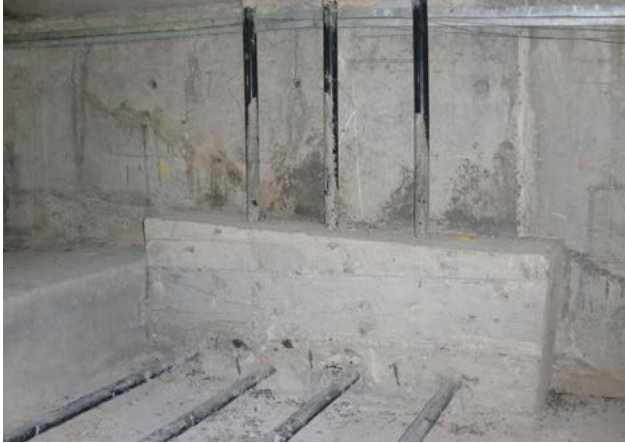
Figure 43 : Précontrainte transversale verticale additionnelle par barres disposées à l'intérieur de la structure
