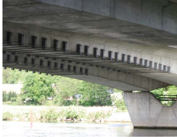
Figure 44 : Précontrainte transversale additionnelle par barres disposées à l'extérieur de la structure avec corsets déviateurs métalliques
