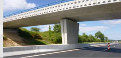
Avec l'arrivée sur le marché de produits marqués CE, certains dispositifs de retenue sur ouvrages d'art transmettent à la structure des efforts sensiblement plus faibles. Ils permettent ainsi d'envisager plus largement l'implantation d'un DR respectant le niveau de retenue obtenu par le calcul de l'ID ou la réglementation.
