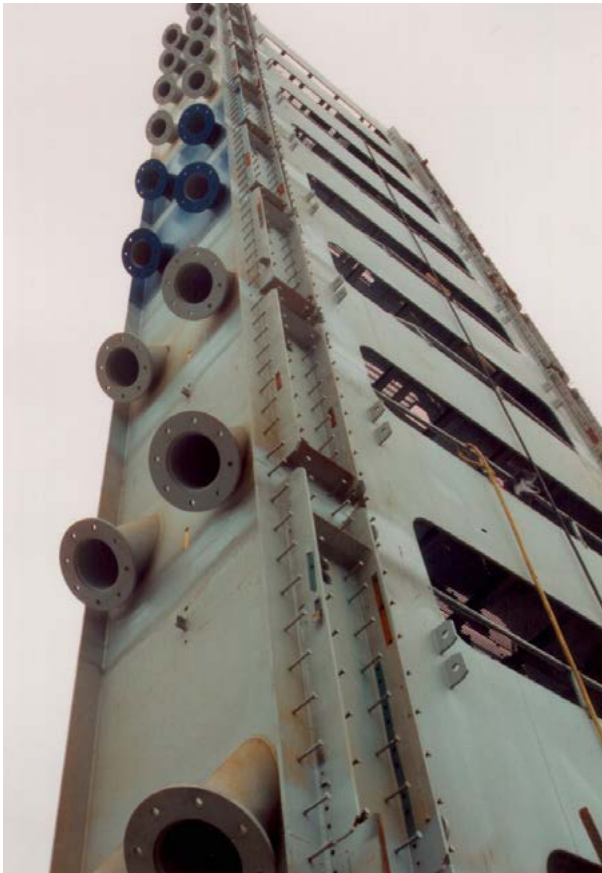
Figure 98 : partie métallique de la tête du pylône du pont de Normandie (France)
