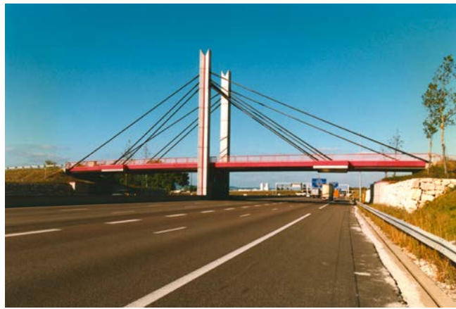
Figure 46 : pont de Beaune (France)
