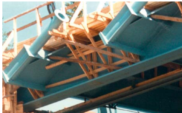
Figure 34 : accrochage des haubans sur le pont de Karkistensalmi
