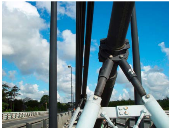
Figure 85 : dispositif antivibratoire utilisé au pont sur l'Elorn
