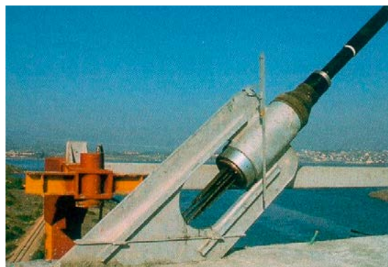
Figure 87 : ancrage bas du pont d'Evripos
