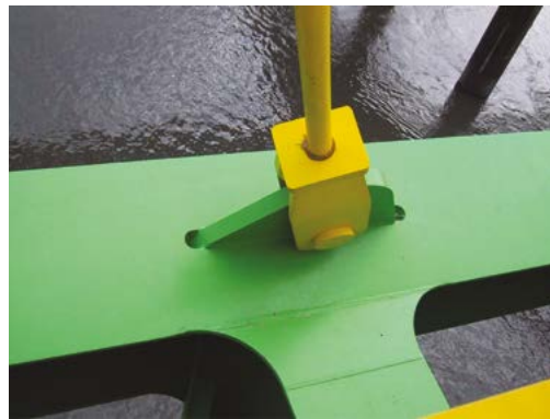
b : Pont de Saint Gilles / suspente (France)
