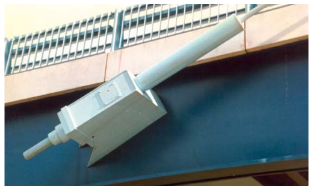
Figure 32 : accrochage des haubans sur le pont de Seyssel
