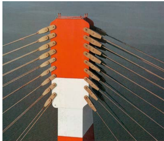
Figure 101 : tête du pylône de Saint-Nazaire
