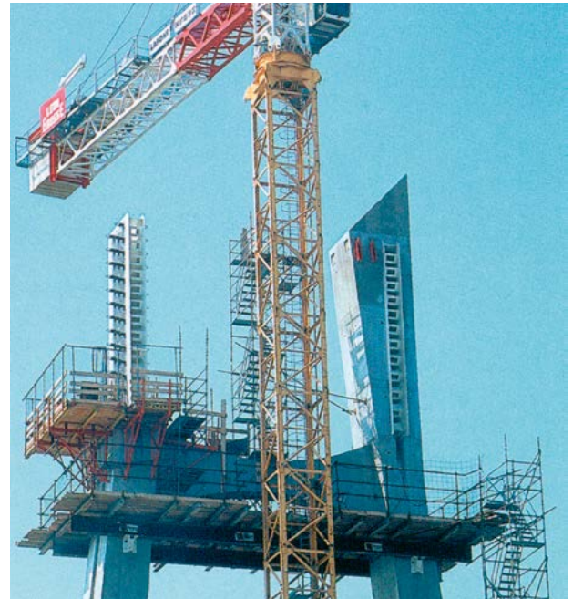
Figure 97 : tête de pylône du pont de Tarascon
