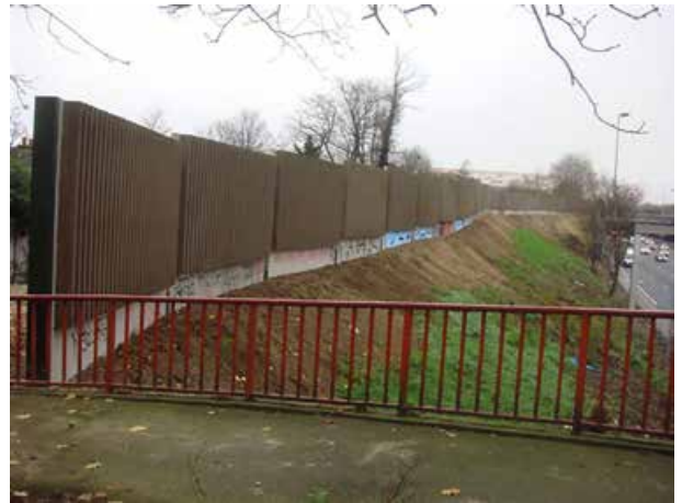
Vue face avant (Source : DRIEA)
