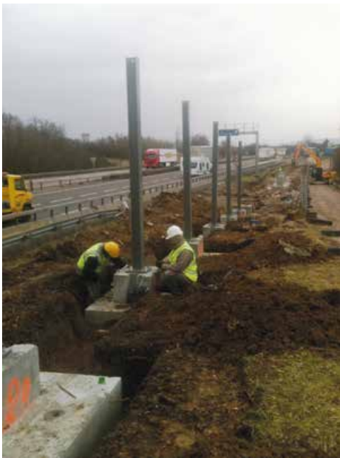
En phase travaux poteau sur semelle (Photo entreprise)
