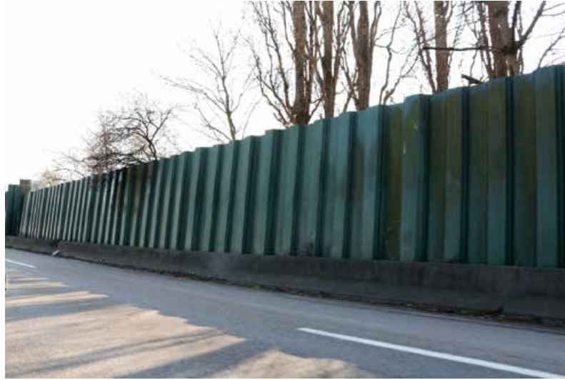
Photo 4 : Ecran en palplanches le long de l'A35 à Strasbourg (67)
