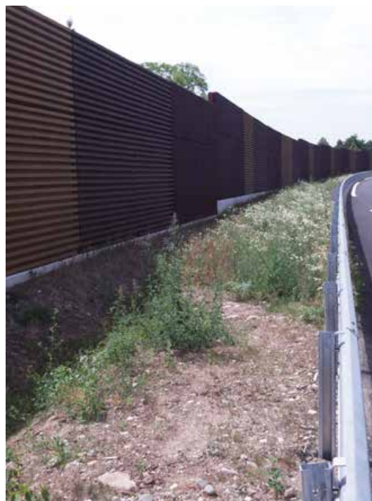
Photo 16 : Exemple d'implantation d'écran à l'arrière d'une glissière de sécurité permettant le débatement du dispositif de retenue
