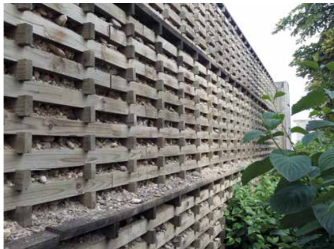
Photo 12 : Protection phonique de type massif « poids » en structure bois
