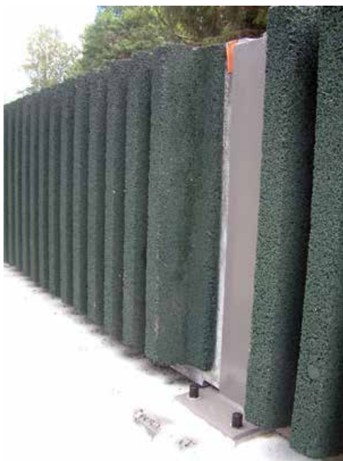
Face avant - poteau et panneaux préfabriqués béton-bois
