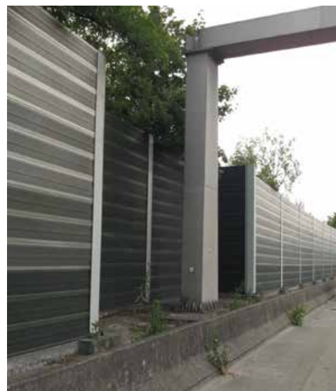
Figure 21 et photo 17 : Exemples d'implantation des massifs de fondation à l'avant de l'écran, une niche peut être localement créée pour recevoir la fondation du dispositif de signalisation
