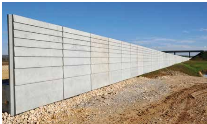
Photo 1 : Ecran en béton le long de la LGV Rhin-Rhône
