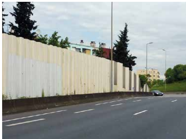
Face avant extrémité Nord
