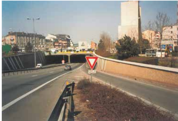
Vue générale avant travaux
