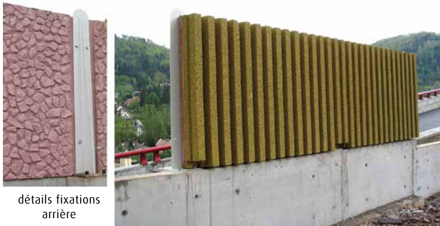
Photo 8 : Ecran avec fixation par l'avant le long de la RD420 au niveau de la commune de Schirmeck (67)
