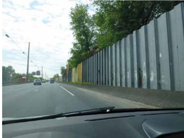
Face avant extrémité Sud raccordement avec tranche 2
