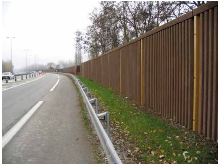
Photo 7 : Ecran absorbant en béton installé le long RD 20 à Kingersheim (68)
