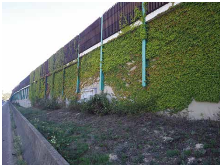
Photo 14 : Exemple d'implantation d'un écran en parement d'un soutènement. Le soutènement protège l'infrastructure routière
