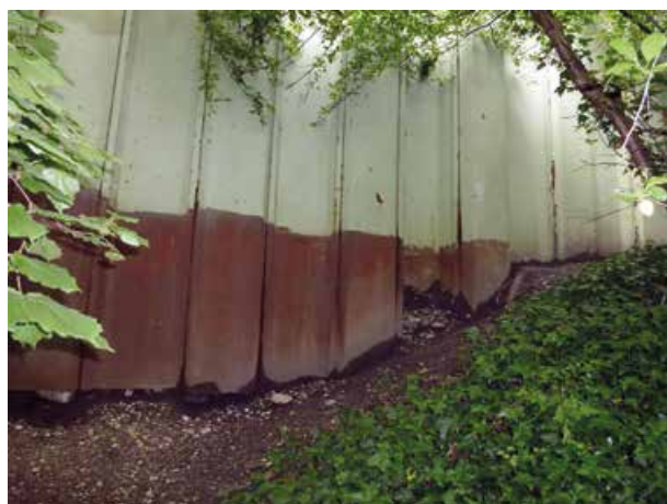
Face arrière. Déchaussement de palplanches intermédiaires dû à l'érosion du talus
