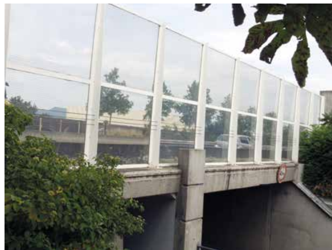
Photos 10 et 11 : Exemples d'écrans sur des tabliers de ponts
