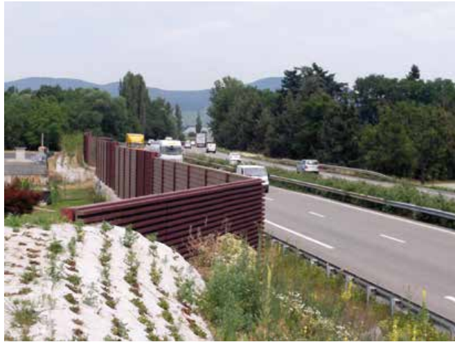
Photo 13 : Au premier plan, protection phonique de type merlon prolongeant un écran acoustique
