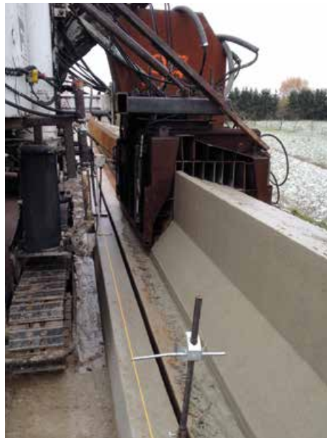
Photo 9 : Réalisation d'une GBA élargie en vue de l'installation d'un écran acoustique
