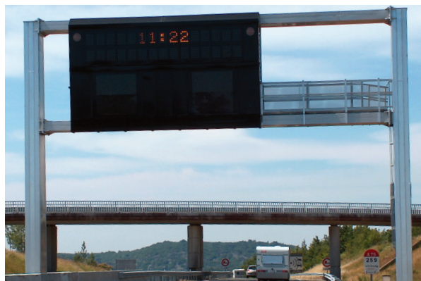
Photo 2 : Portique double traverse (porteur d'un caisson PMV)
