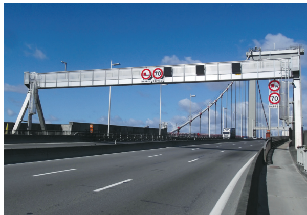
Photo 10 : Portique à montants doubles
