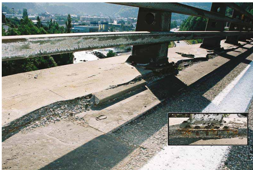
Figure 6. Barrière sur longrine de faible épaisseur (Cerema/DTERCE)
