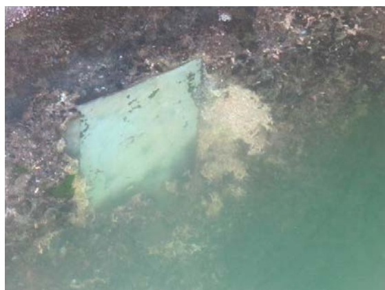
a) Immédiatement après décapage
