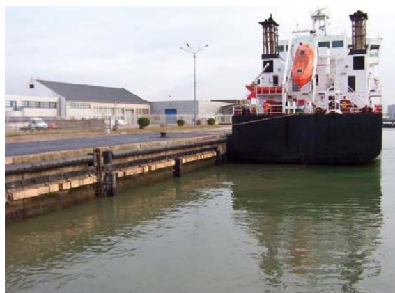
Système de protection des têtes de tirants et de la lierne de répartition
