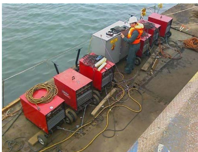
b) Ponton support pour les travaux avec les alimentations nécessaires au chantier
