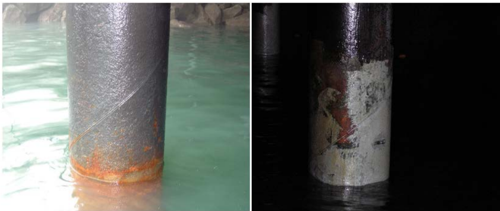
Figure III.4.1 - Pieux peints sur la partie accessible à marée basse - première et deuxième couches
