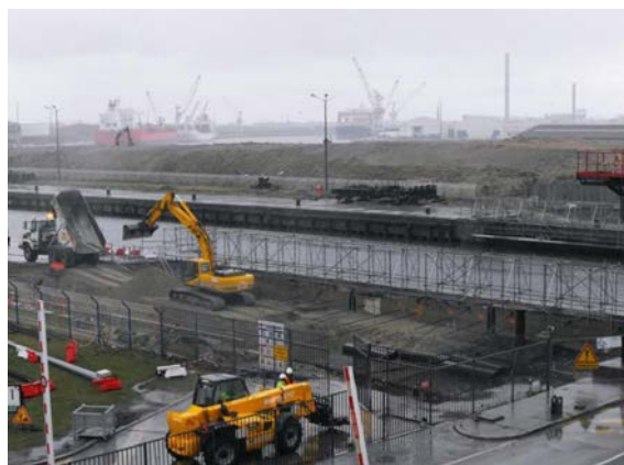
travaux de terrassement et pose du nouveau lit supérieur
