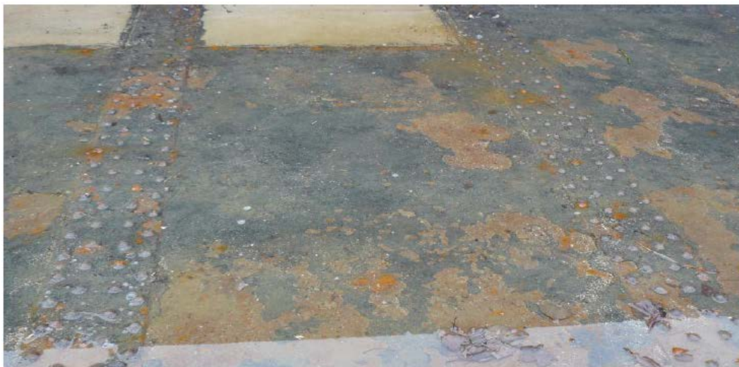
Figure IV.4.2 - Vue du fond de la bête du pont-canal de Briare - crédit CETE Normandie-Centre
