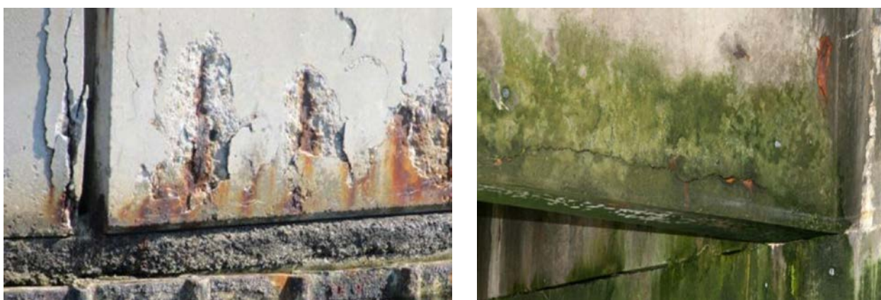
a) Couronnement de gabion métallique
