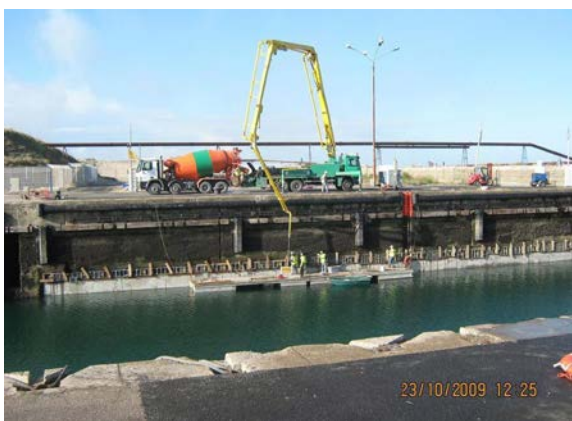
La protection béton de la partie supérieure des palplanches en cours de coulage
