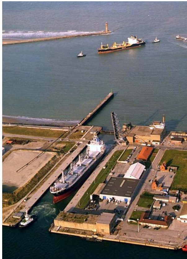
Figure IV.2.1 - Vue générale de l'écluse de Watier du port de Dunkerque
