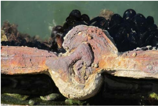
a) Serrure entre deux palplanches plates
