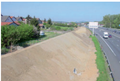
Photo 2 : autoroute A43 L'Isle-d'Abeau (AREA)
