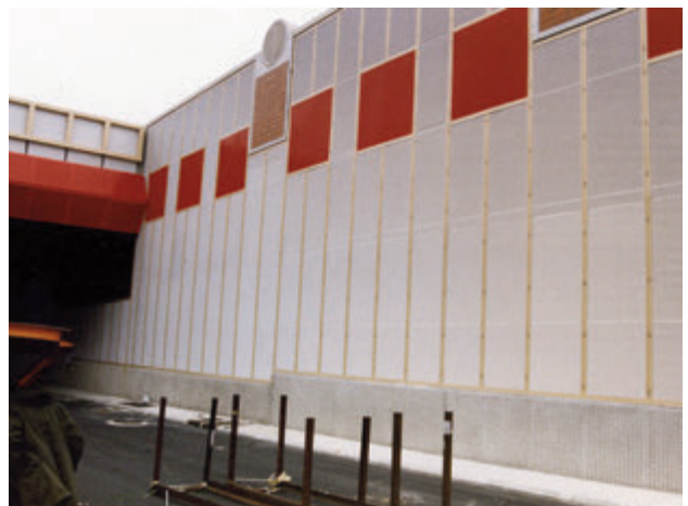
Photo 23 : parement absorbant composé de panneaux de fibre de roche protégés par une grille en métal perforé (A86, Bobigny)
