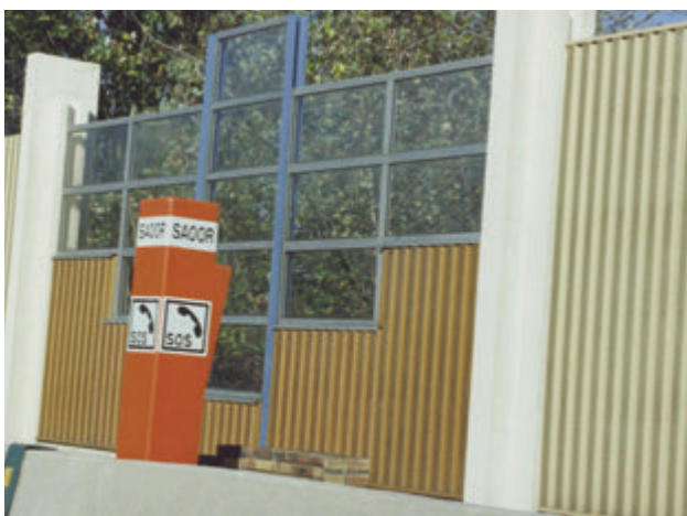
Photo 5 : écran réfléchissant/absorbant composé de poteaux en béton, de panneaux de polycarbonate et de panneaux métalliques (A6, Arcueil)
