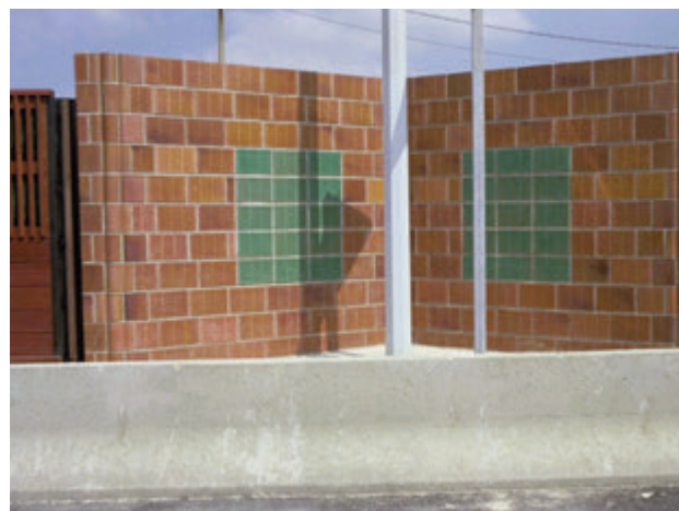
Photo 16 : écran absorbant composé de poteaux métalliques et de panneaux en briques acoustiques bicolores (A86, Rosny-sous-Bois)
