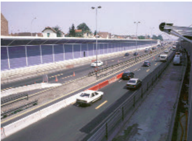
Photo 24 : parement absorbant composé de panneaux de fibre de roche protégés par une grille en métal perforé, mis en œuvre sur des soutènements en béton (A1, Le Blanc Mesnil)
