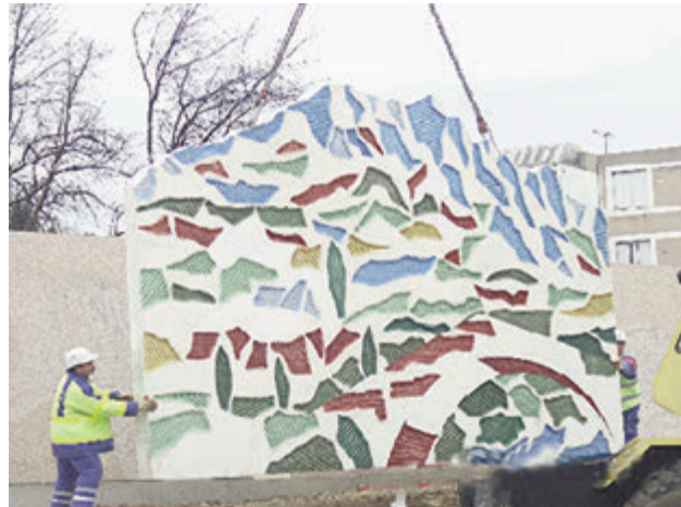
Photo 25 : panneau décoratif en cours de pose au sein d'un écran réfléchissant composé de poteaux métalliques et de panneaux en béton (A8, Aix -3 Sautets)
