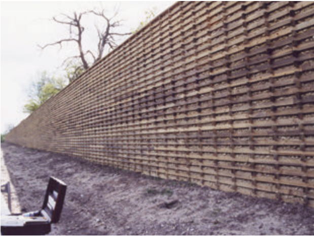
Photo 21 : écran réfléchissant composé de gabions en bois remplis de grave (Toulouse)
