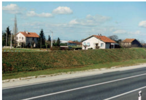
Photo 4 : déviation de Valence (DDE26)
