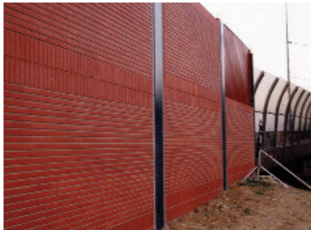
Photo 18 : écran réfléchissant composé de poteaux métalliques et de panneaux en briques pleines (voie de desserte de l'aéroport, Blagnac)
