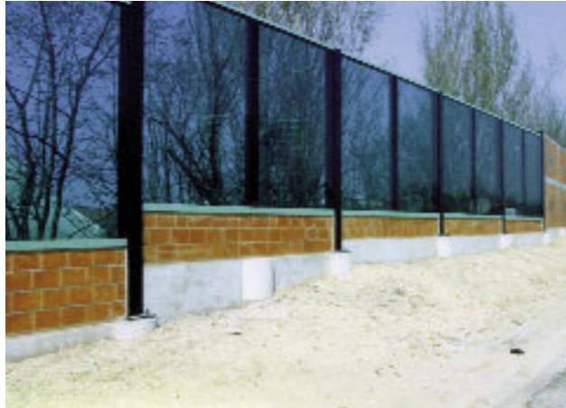
Photo 4 : écran réfléchissant/absorbant composé de poteaux métalliques, de panneaux de polycarbonate et de briques absorbantes (A3, Bobigny)
