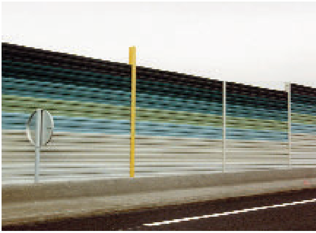
Photo 1 : écran réfléchissant composé de panneaux et de poteaux métalliques (rocade ouest, Lille)
