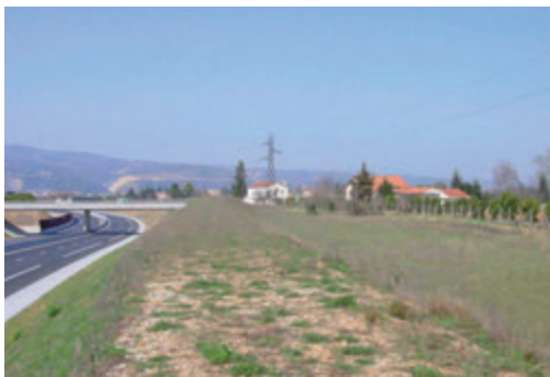
Photo 1 : déviation de Bourg-lès-Valence (DDE26)
