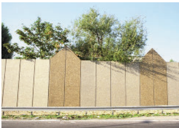
Photo 15 : écran réfléchissant composé de panneaux préfabriqués en béton (A1, Le Bourget)
