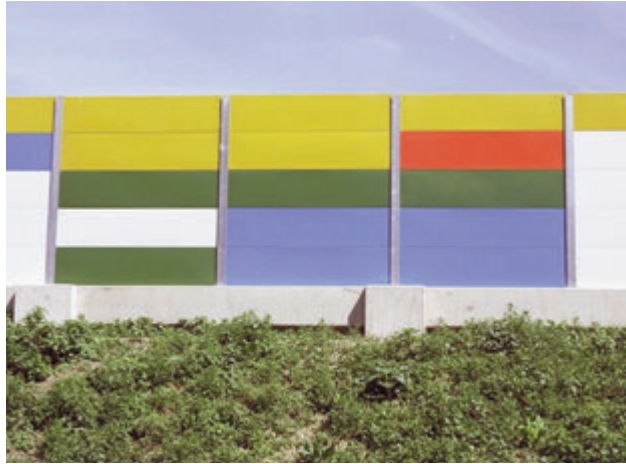
Photo 2 : écran absorbant composé de caissons et de poteaux métalliques (RN 118, Orsay)
