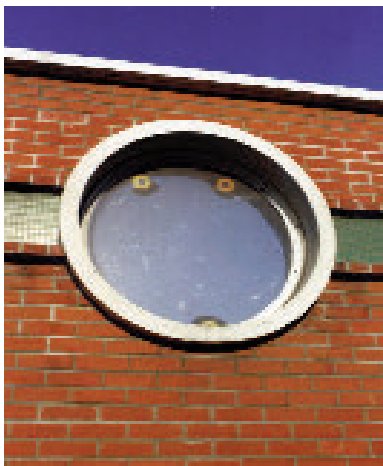
Photo 19 : écran réfléchissant composé de poteaux métalliques et de panneaux en briques pleines avec hublots en polycarbonate (A1, Saint-Denis)
