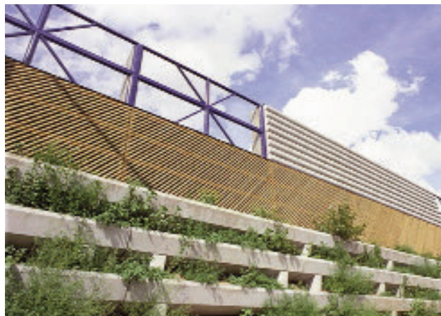
Photo 20 : écran absorbant/réfléchissant composé d'un soubassement végétalisable et de panneaux en bois et en méthacrylate (A1, Saint-Denis)
