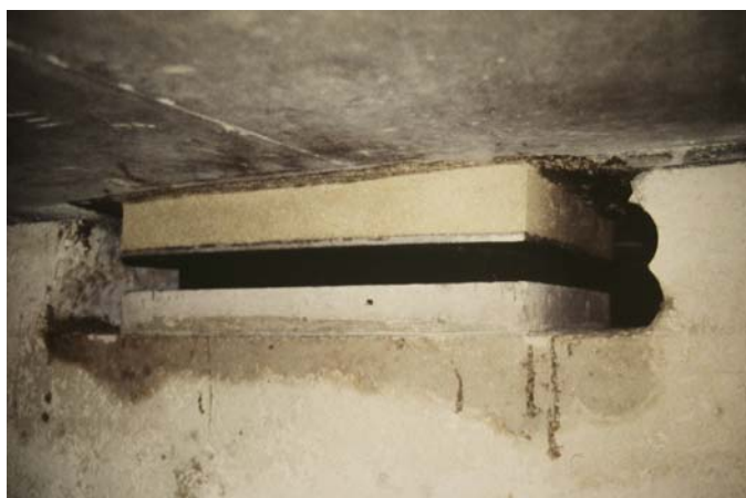
Photo 46 – Appareil d’appui sur culée après vérinage à tablier zéro : niche carottée, bossage inférieur préfabriqué collé + AA + matage sur plaque en acier inoxydable perdue
