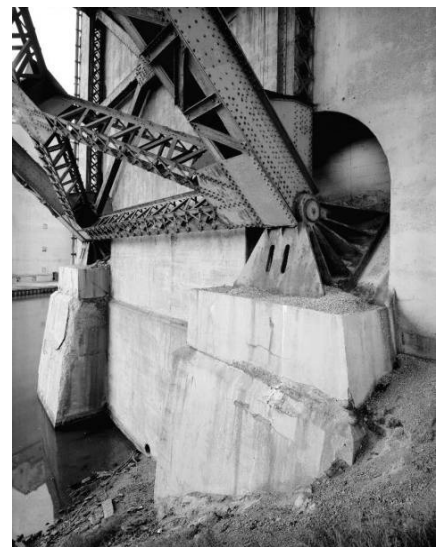
Photo 10 – Rotules axiales d'un pont en arc
