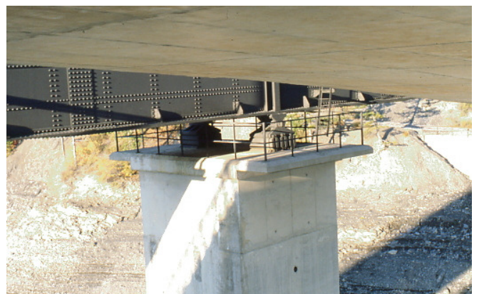
Photo 14 – Pendule métallique + rotule
