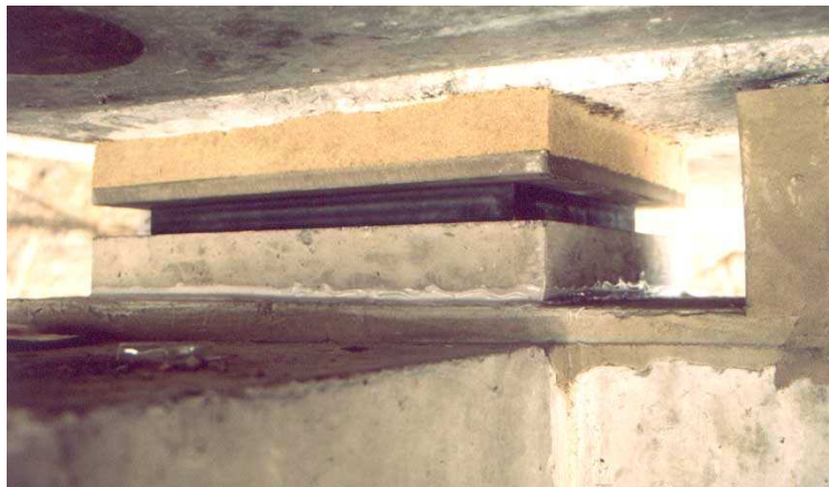
Photo 44 – Matage sous tablier de pont-dalle
