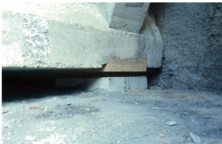
Photo 45 – Matage sous talon de poutre de V.I.P.P
