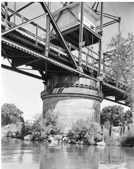
Photo 21 – Pont tournant – Vue générale de la pile avec appareil d'appui rotatif
