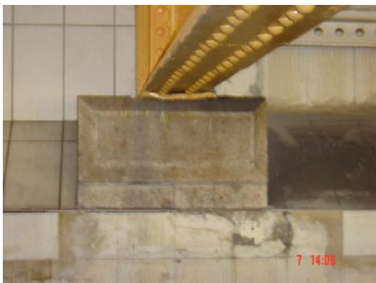
Photos 18 et 19 – Semelle de plomb sous poutre métallique
