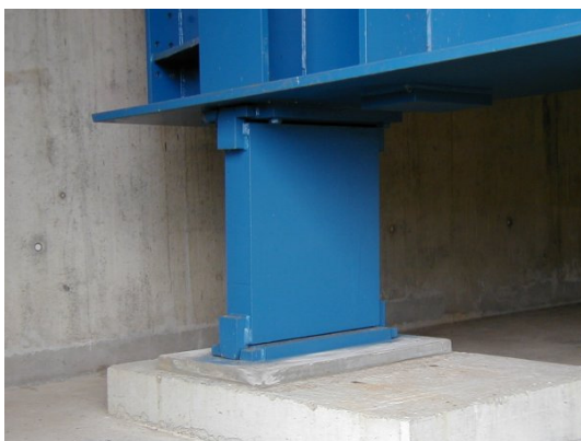
Photo 13 – Pendule métallique équipant un pont mixte
