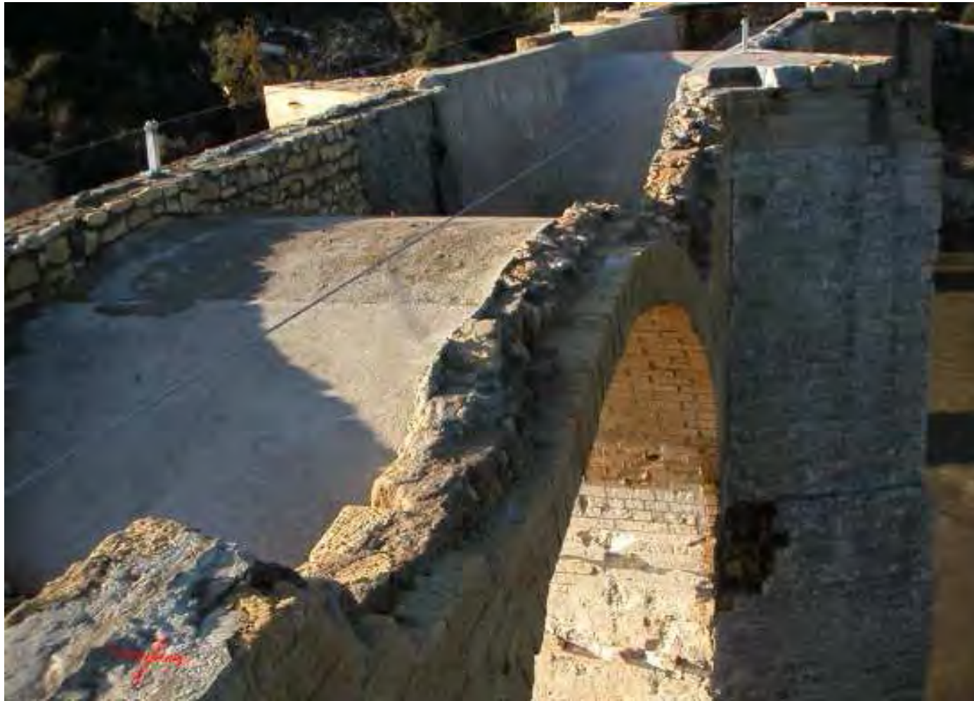
Ouvrage avec matériaux de remplissage enlevés
