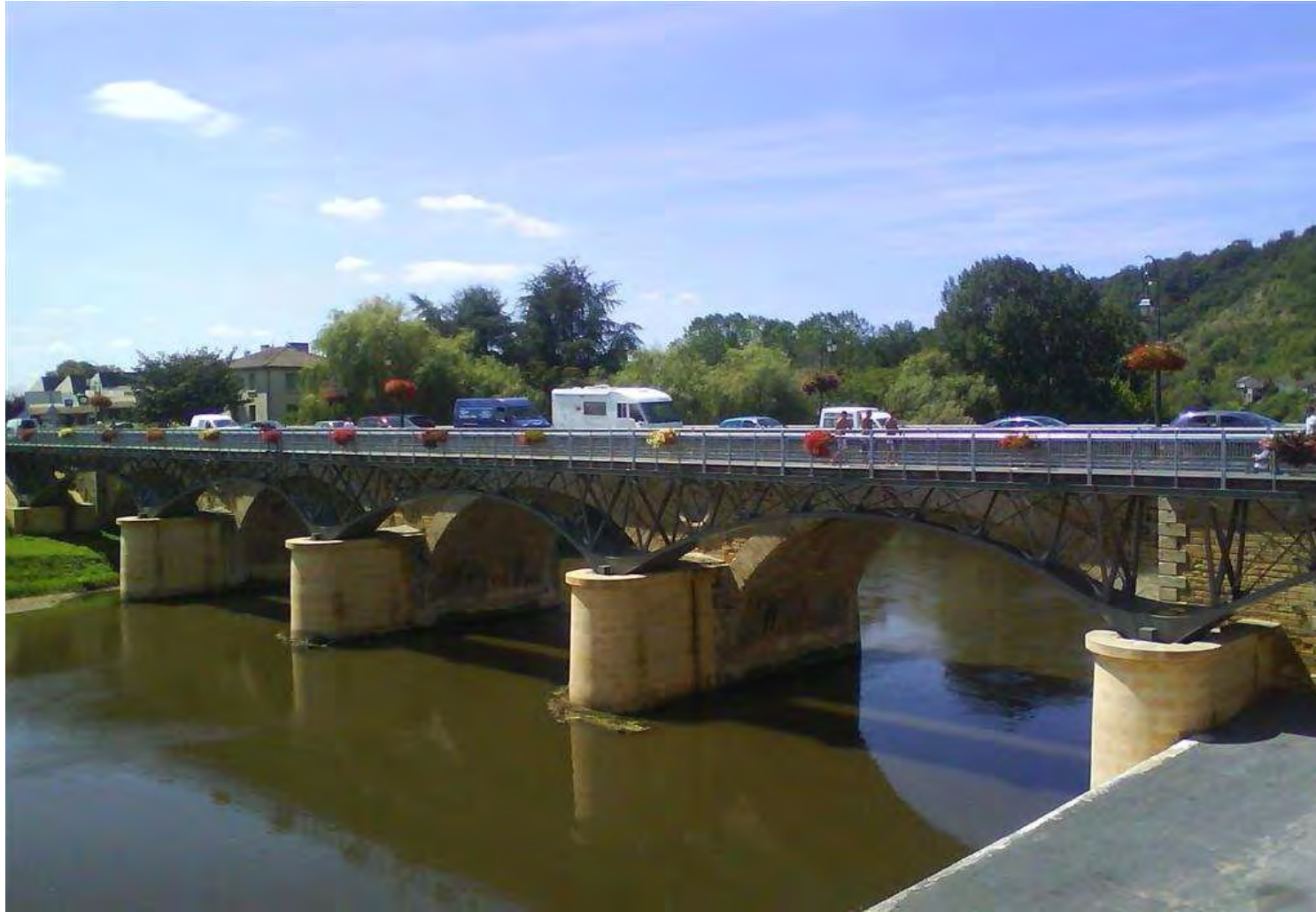
Élargissement par ouvrage métallique
