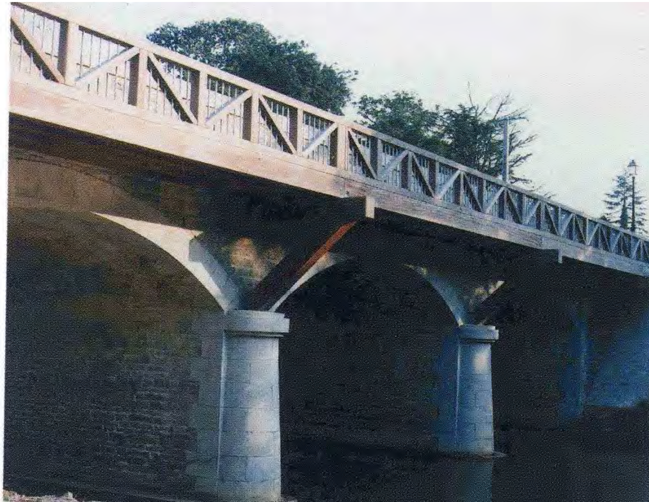
Élargissement par structure bois
