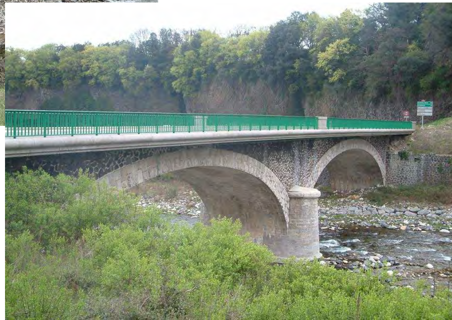
Vues de l'ouvrage élargi
