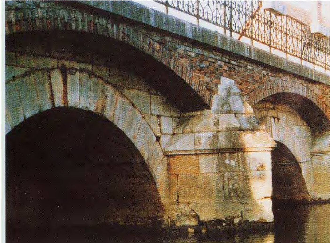
Élargissement par voûte en briques
