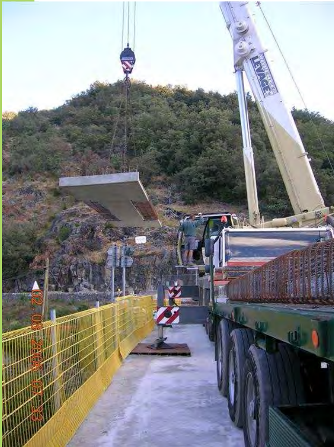
Pose d'une dalle préfabriquée
