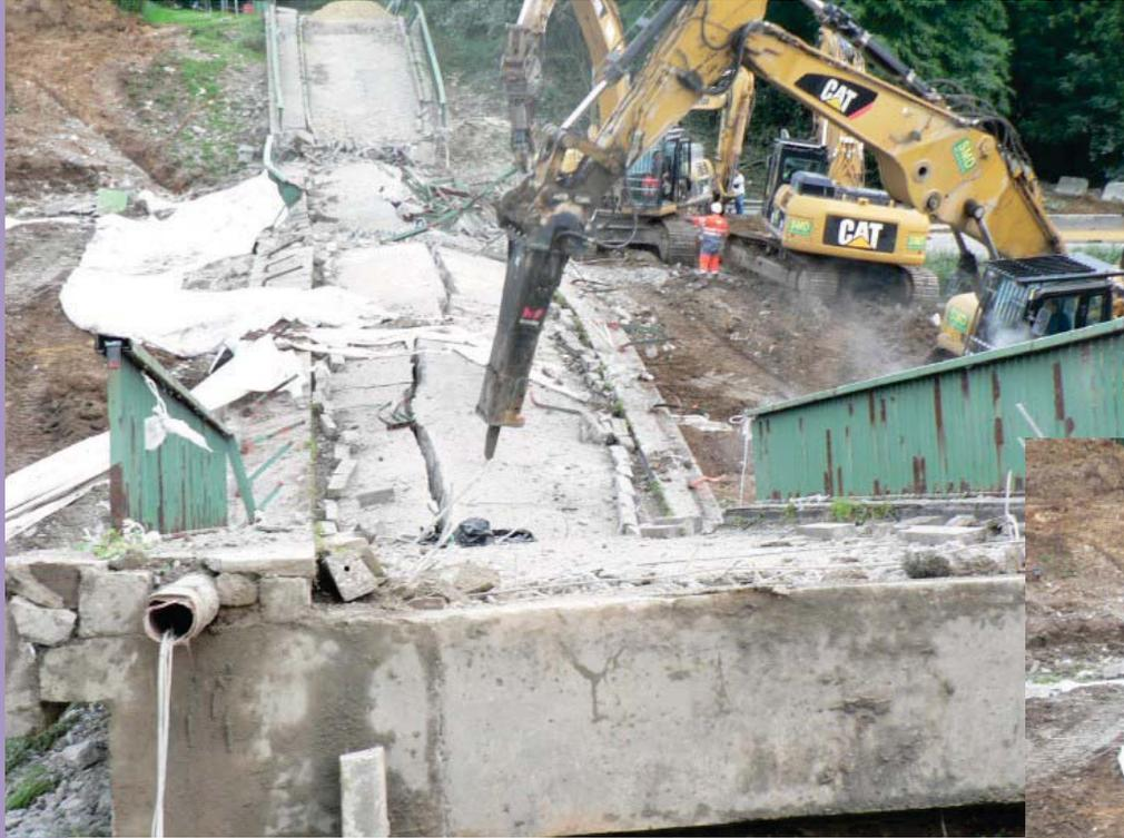
*BRH fracturant le béton*
