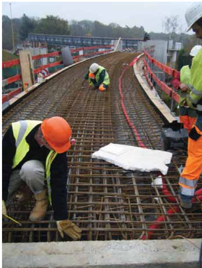
Tablier OABA / ferrailage
