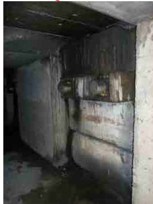
Vues de la galerie technique et des ancrages des câbles de renfort de 1967 et 1990
