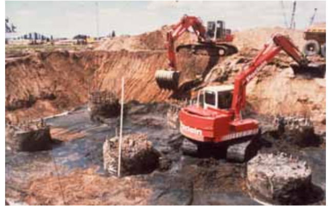
Pieux forés (photo LRPC de Lyon)
