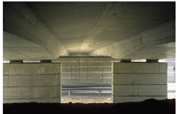
PSIDN sur appareils d'appui en élastomère fretté (Photo Sétra/CTOA)
