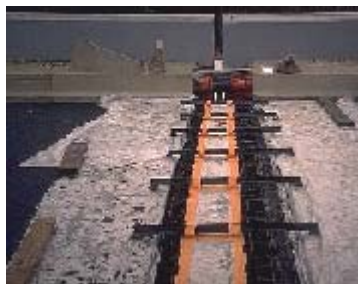
joint de chaussée avant bétonnage (photo Sétra/CTOA)
