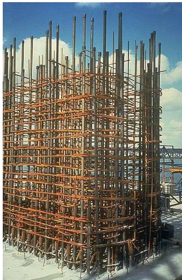
Cage d'armatures (Photo Sétra/CTOA)
