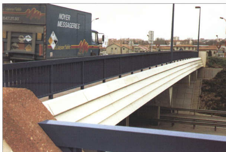
Fig. 90 Corniche en polyester armé de fibres de verre. Voir aussi la figure 14.
