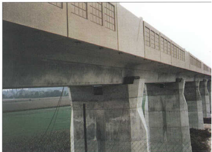
Fig. 11. Sur cet ouvrage portant une voie TGV, la corniche et l'écran acoustique forment un ensemble.
