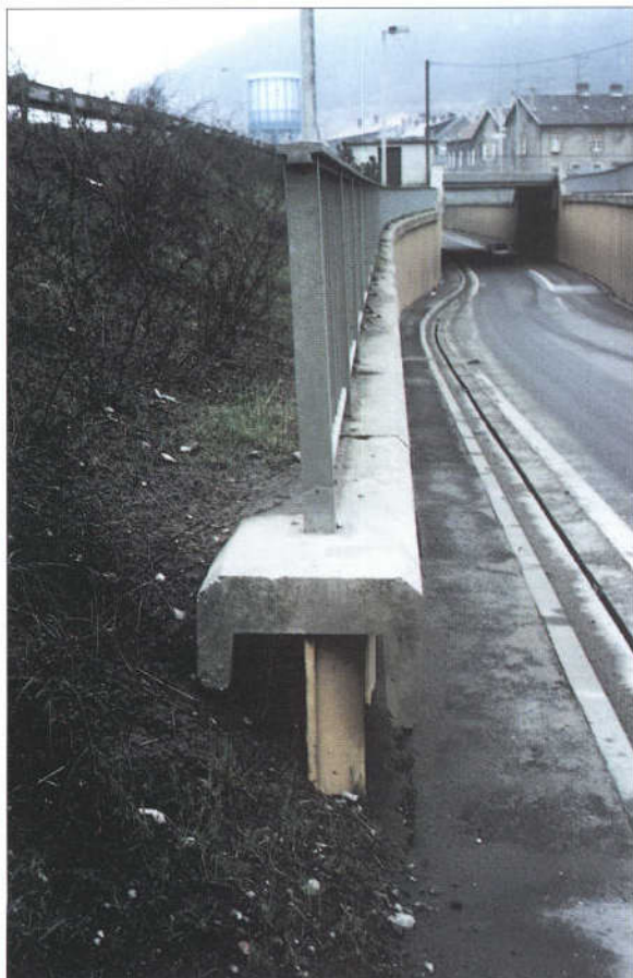
Fig. 1. Vue en coupe d'une corniche en couronnement d'un mur de soutènement.
