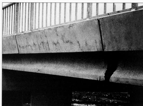
Fig. 21. Faute d'un traitement correct du joint entre éléments préfabriqués, l'eau passe et ruisselle sur la poutre.
