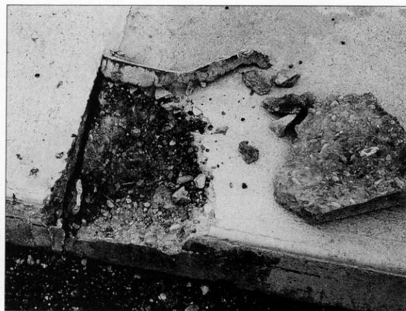
Fig. 22. Tenue peu convaincante d'un mastic de jointoiment et d'étanchéité entre les éléments préfabriqués.
