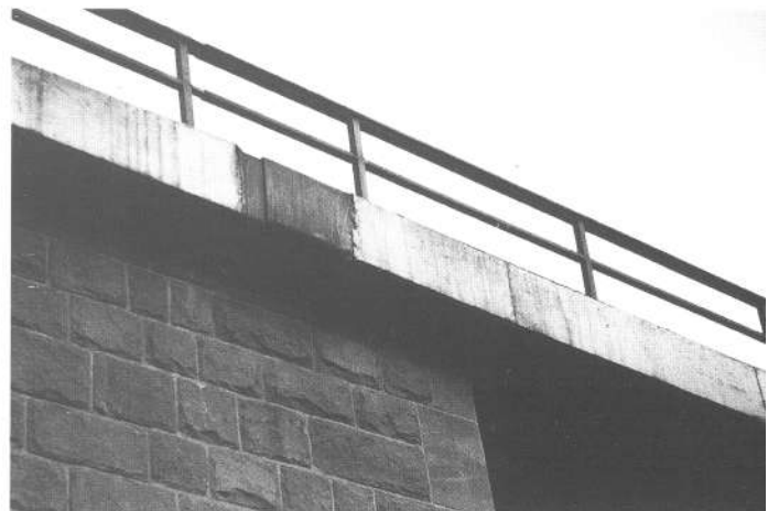
Fig. 29.c. Autre solution : le couvre joint de dilatation de corniche.
