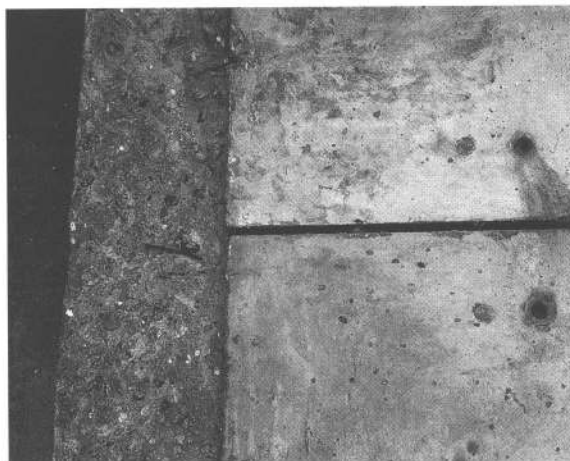
Fig. 26. Corrosion des inserts utilisés pour la manutention et laissés en place.
