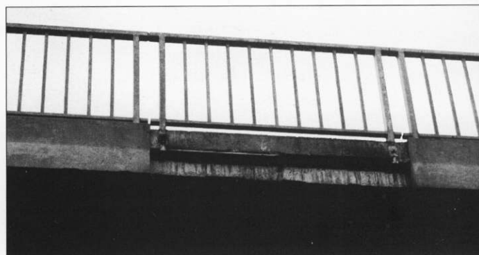
Fig. 20. Chute d'un élément de corniche consécutive à une corrosion des attaches.
