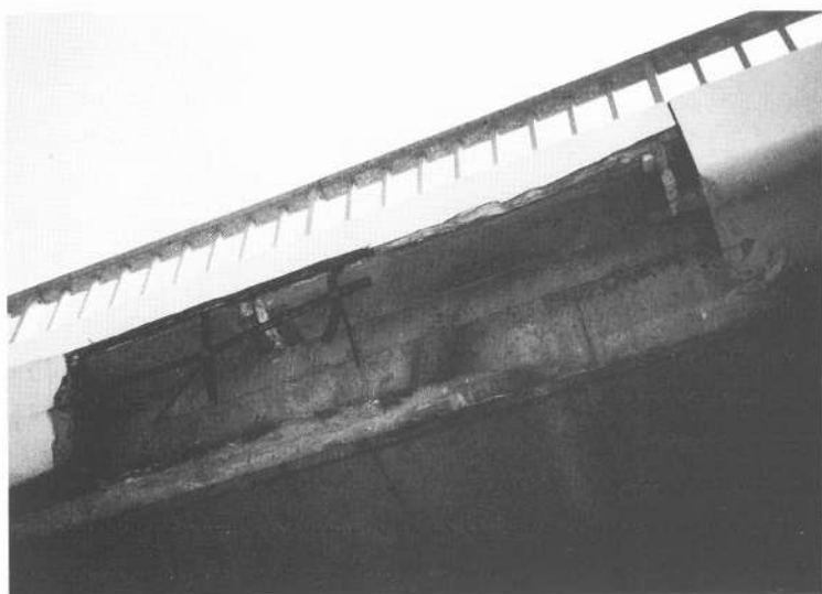
Fig. 40. Les corniches en CCV sont très fragiles aux chocs. (Photo DDE 87)
