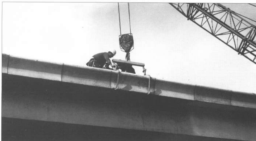
Fig. 27b. Levage à l'aide d'un portique. Noter l'absence de sécurité du personnel travaillant en bord du vide.
