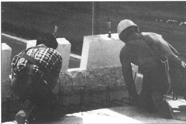
Fig. 46. Mise en place des éléments. On notera que les ouvriers sont équipés de harnais de sécurité individuels. A comparer avec la situation de la figure 27b.
