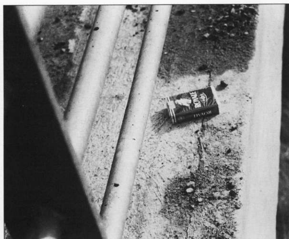
Fig. 19. Fissure de retrait entre la corniche et la contre-corniche qui sera le point de pénétration de l'eau et peut entraîner, à la longue, une désorganisation des liaisons.
