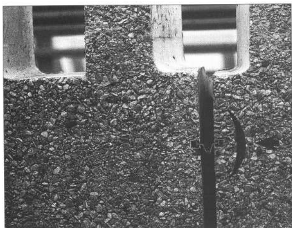
Fig. 23. Un exemple de joint avec profilé en plastique.
