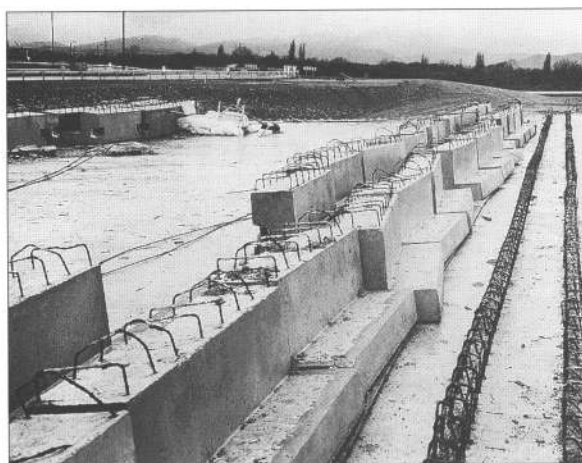
Fig. 25. Un exemple de calage sur un mortier parfaitement réglé au préalable.
