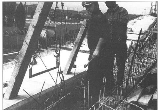
Fig. 47. Les conditions de mise en place des corniches ne semblent pas avoir été examinées sous l'angle de la sécurité des ouvriers : marche au milieu des aciers, absence de sécurité, élingues, etc.
