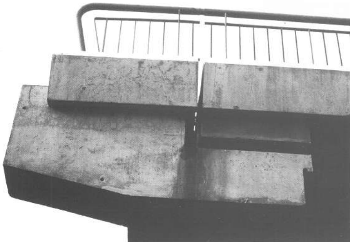
Fig. 29 b. Le vide au passage du joint du pont rompt la continuité apparente de la corniche.
