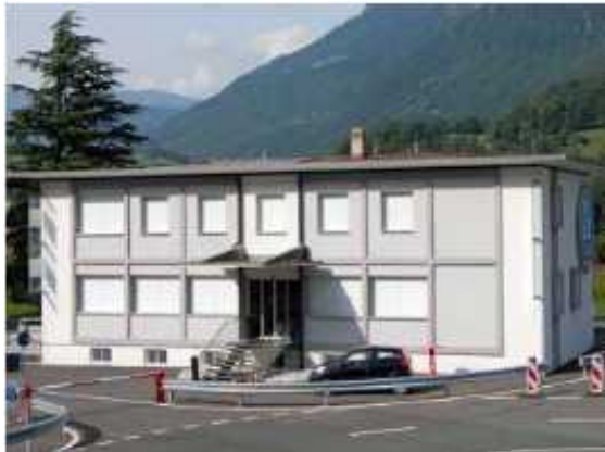
Vue façade avant après renforcement
