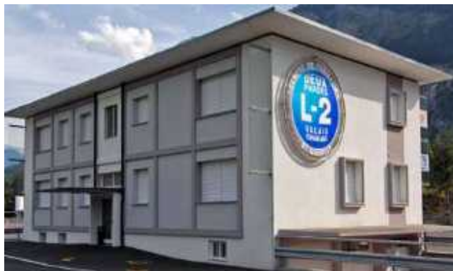
Vue façade arrière après renforcement
