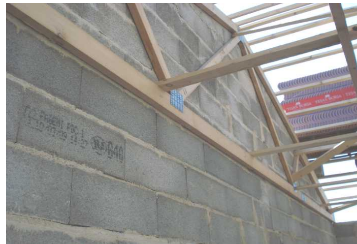
Ancrage de la charpente
