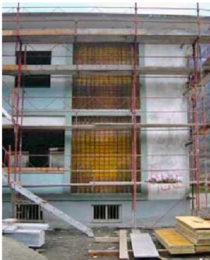
Travaux : armature nouveau voile
