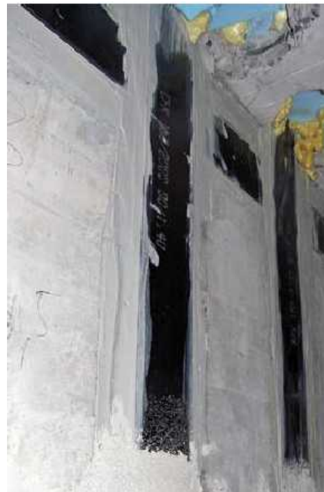
Renforcement des noyaux d'ascenseurs
