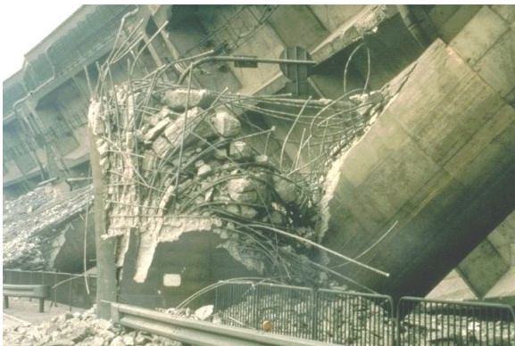
Densité importante d'armatures d'efforts tranchants
