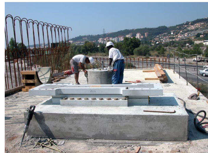
Blocage transversal sur culées
