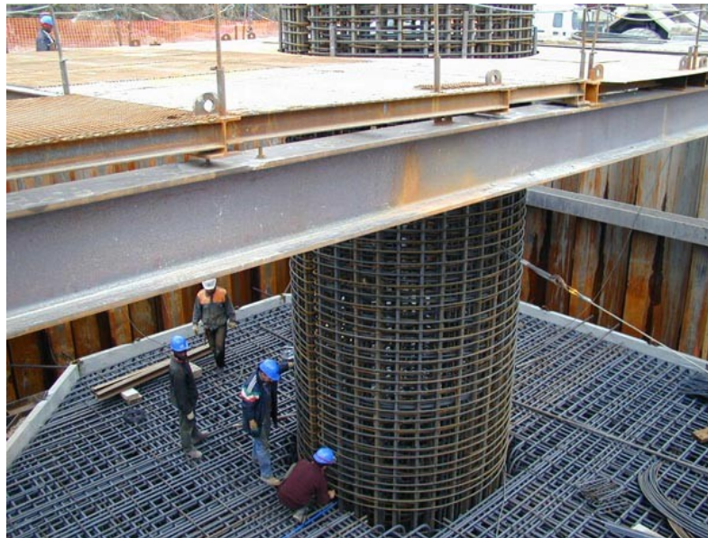
Ferrailage d'un fût de pile
