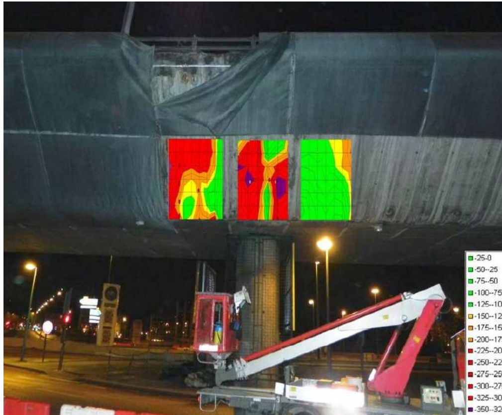
Mesures de potentiels sur les parements du Viaduc de Saint Cloud
