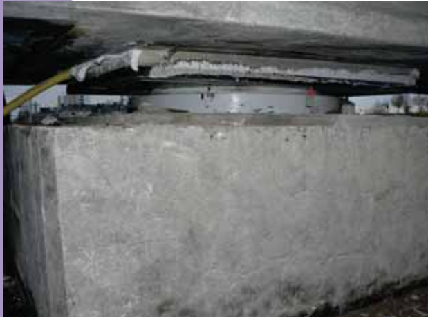
Réalisation matage supérieur
