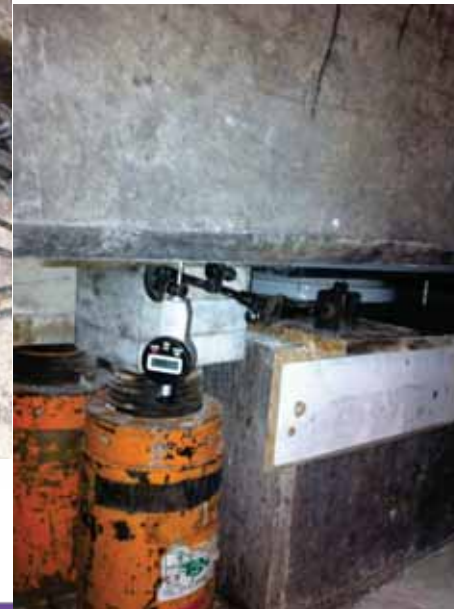
Réalisation matage inférieur
