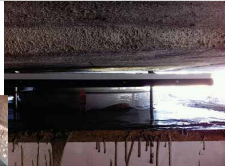
Réalisation matage inférieur
