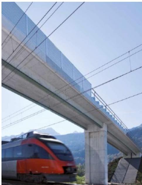
Pont de Vigaun (Autriche) – 3 travées de 26m 15 Long 79m
