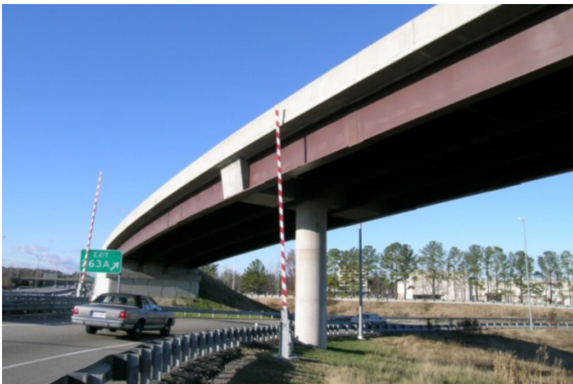
Pont intégral sur culée et piles
