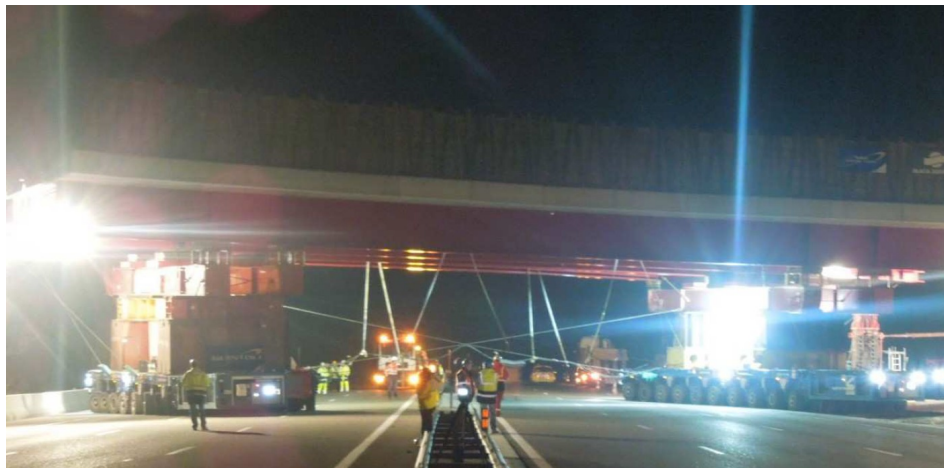
Photo : SIR 34 – Passage à grande faune au dessus de l'A8 à Brignoles
