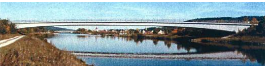
Southern Viaduct Berching – Portée de 106m50
