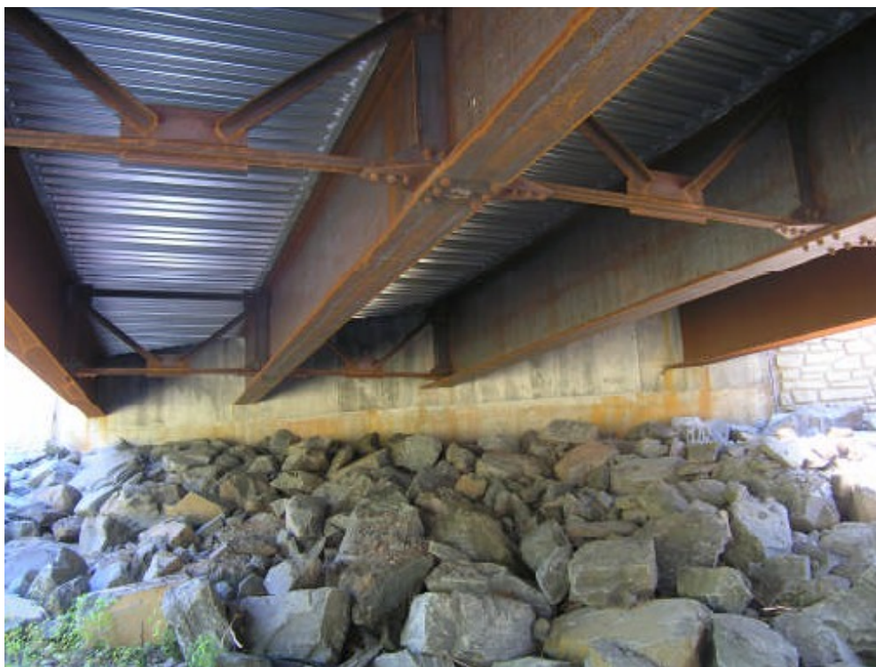
Exemple de pont à poutres métalliques
