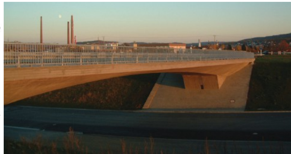
Pont n°5 sur autoroute B14 près de Winnenden – Art. Beton und Stahlbetonbau 99 (2004) – Photo Peter&Lochner
