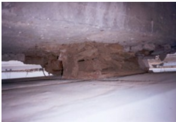
Destruction d'un AA métallique
