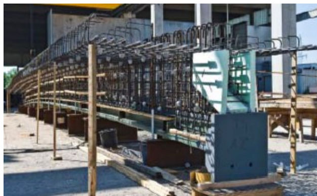
Pont de Vigaun (Autriche) – 3 travées de 26m 15 Long 79m
