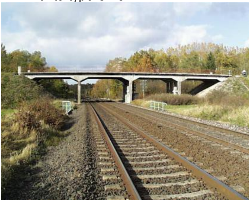
Pont de Méhoncourt sur RD9 – Ligne Nancy-Belfort – 1938 – Photo CG54
