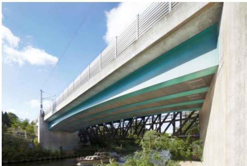
Pont-rail sur le canal de Teltow à Berlin – Portée de 42m65 – Procédé breveté VFT® de SSF
