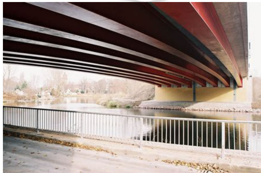
Pont sur la Saale à Merseburg – Portée de 55m40
