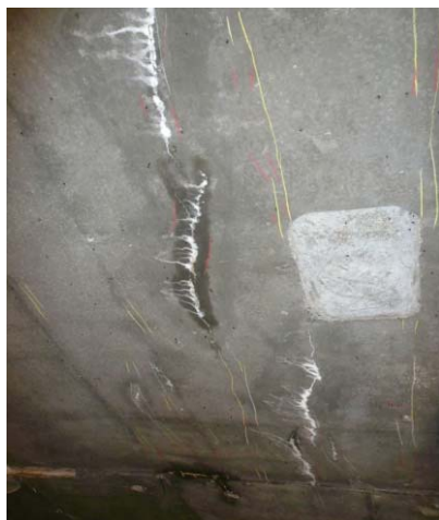
Facteur aggravant: trace de rouille
