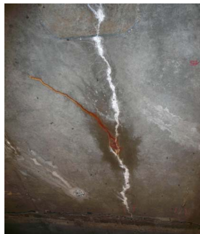
Facteur aggravant: trace de rouille
