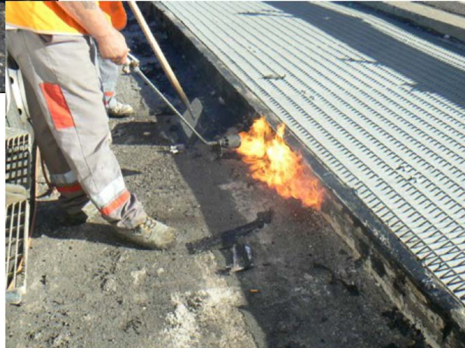
Décollement de la feuille préfabriquée à la flamme et raclette →
