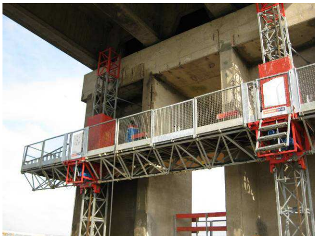
Plateforme de travail hissée
