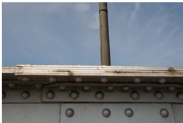
Corrosion entre tables Des membrures
