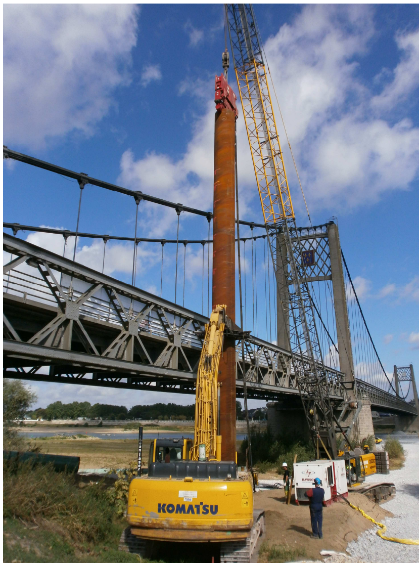
Vibrofouçage d'un tube en terrestre Pelle PC350 équipée d'un guide de battage Grue flèche treillis 110 tonnes Vibreur 38 M et groupe hydraulique associé
